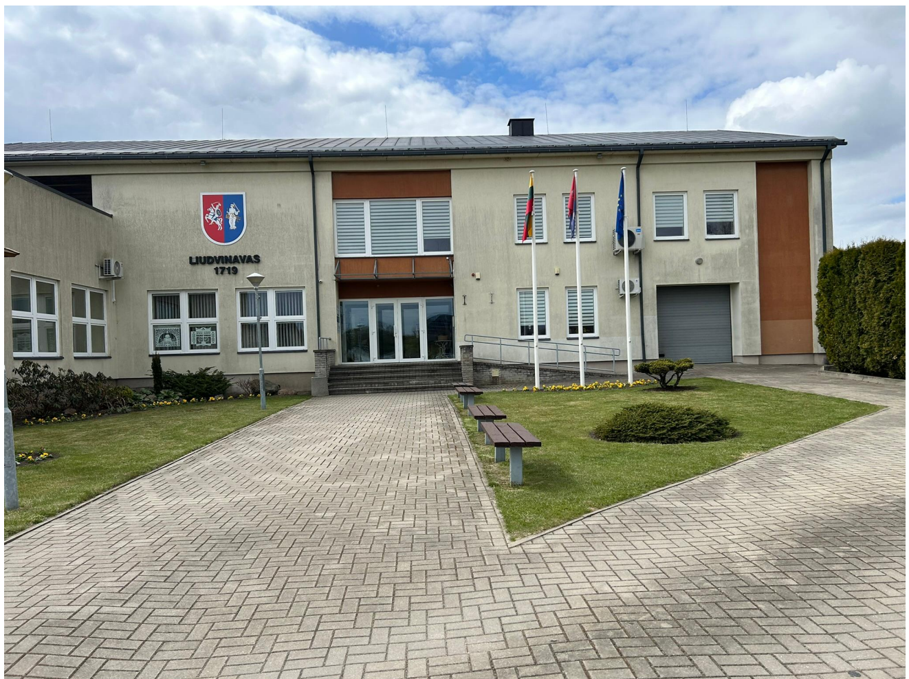
Pav. 2. Rytų fasadas, pagrindinis įėjimas.
