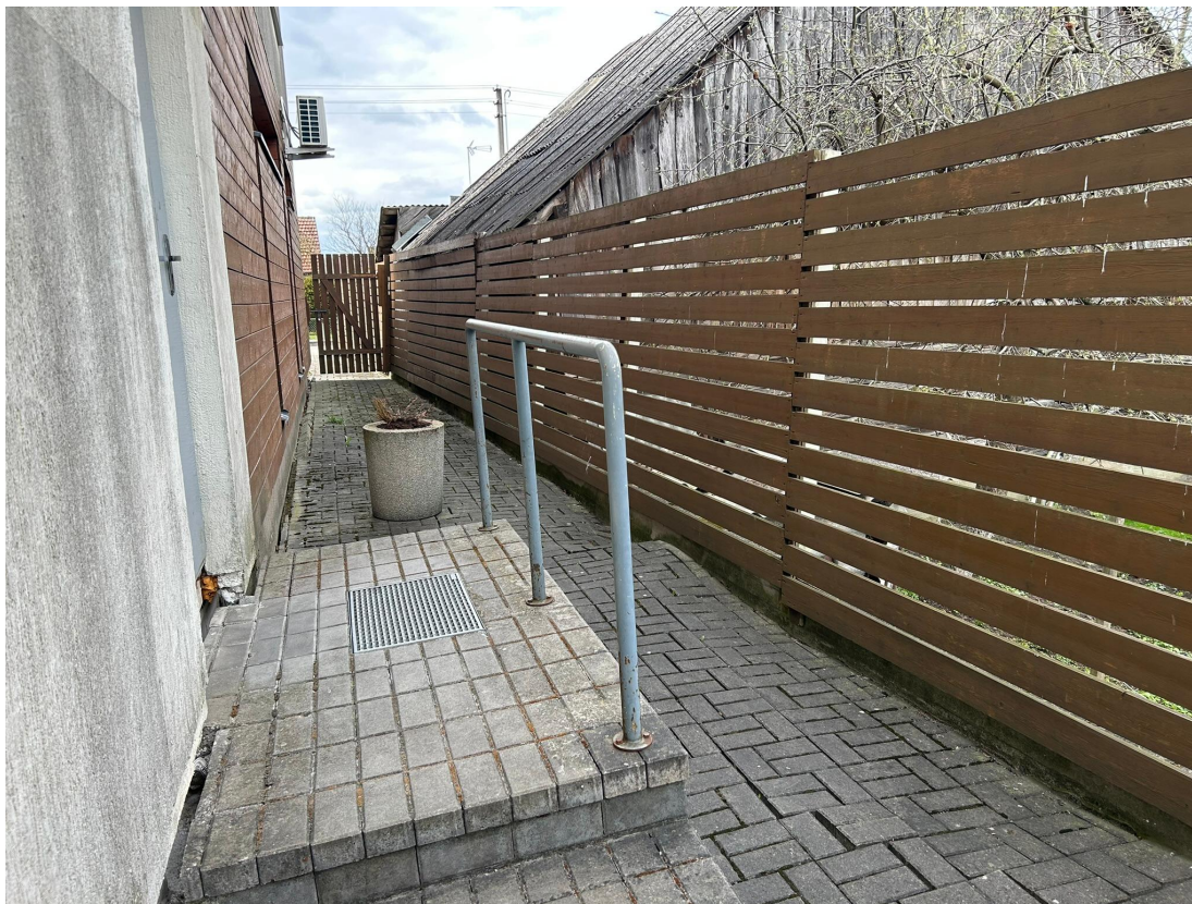
Pav. 6. Atraminė sienelė ir trinkelų dangos.
