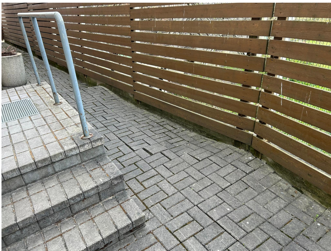
Pav. 5. Atraminė sienelė ir trinkelų dangos.
