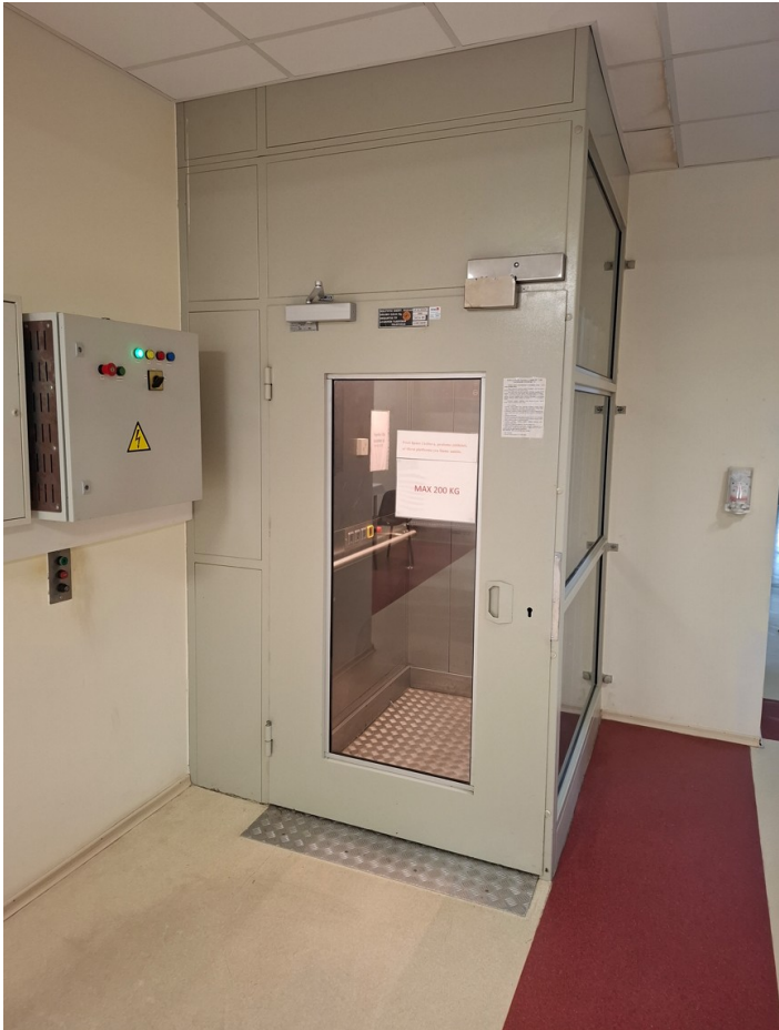
1 pav. Remontuojamo pastato vidaus patalpų fotofiksacija (2025-10 mėn.). Esamas keltuvas.
