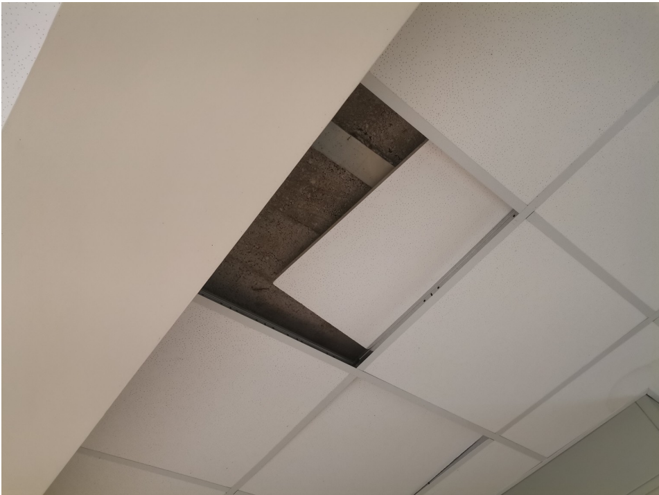
2 pav. Remontuojamo pastato vidaus patalpų fotofiksacija (2025-10 mėn.). Perdangos apžiūra šalia esamo keltuvo. Įrengta gelžbetoninė monolitinė perdanga ant kurios sumontuotos pakabinamos lubos.
