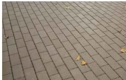
4.4 pav. Betoninių trinkelų danga automobilių stovėjimo vietoms
