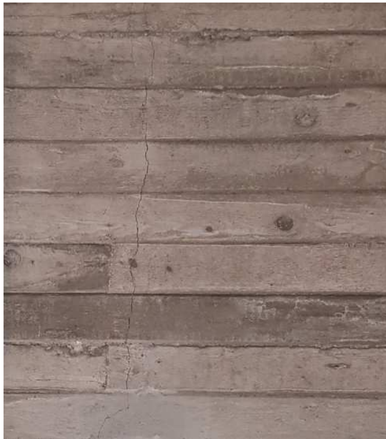
12 pav. Įtrūkimai vidinėje laikančioje sienoje
