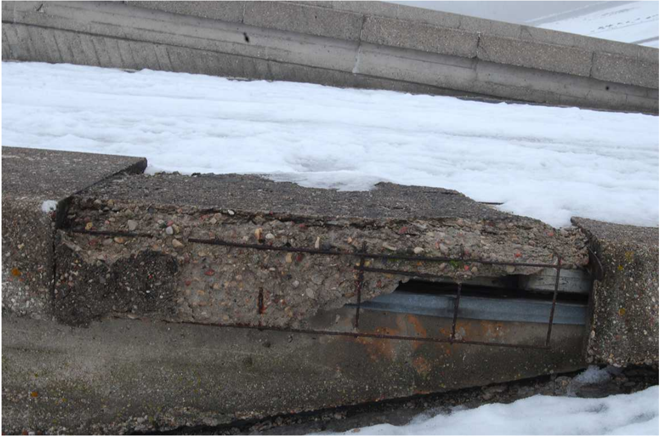
22 pav. Ištrupėjusios kampinio profilio stogo dangos apdailinės plokštės
