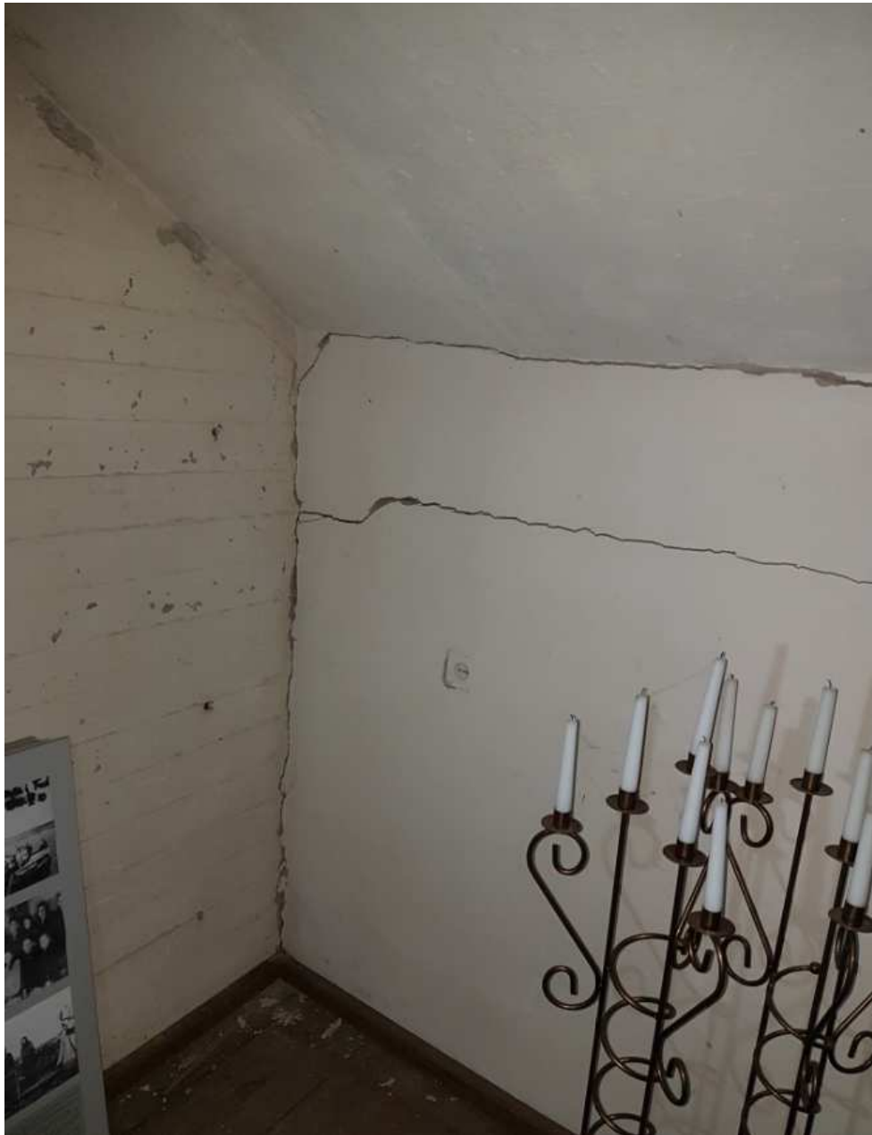
15 pav. Suskilusios nelaikančios pertvaros
