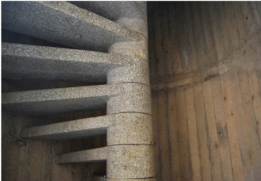
23 pav. Vidiniai gelžbetoniniai laiptai
