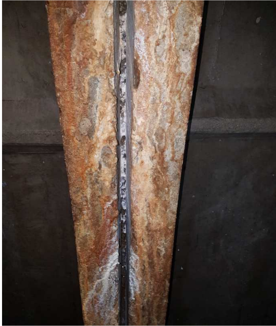
17 pav. Briaunuotos surenkamos denginio plokštės pažeistos drėgmės poveikio
