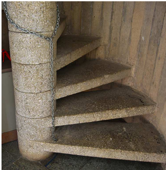
24 pav. Vidiniai gelžbetoniniai laiptai
