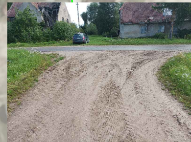
Pk 11+37 Naikinama nuovaža Į sodybą Neregistruota Esama danga - žvyras apaugęs žole
