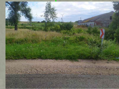
Pk 12+06 Naikinama nuovaža Į sodybą Neregistruota Esama danga - žvyras apaugęs žole
