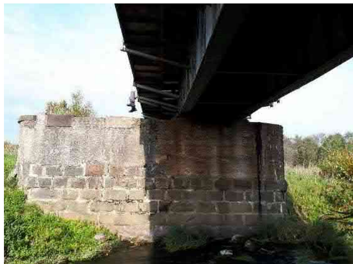
Pav. 9 Upės vaga ir jos šlaitai užversti tilto atramų nuolaužomis (rieduliai, granitiniai blokai). Vagos šlaitai po tilto nelygūs, apaugę žole
