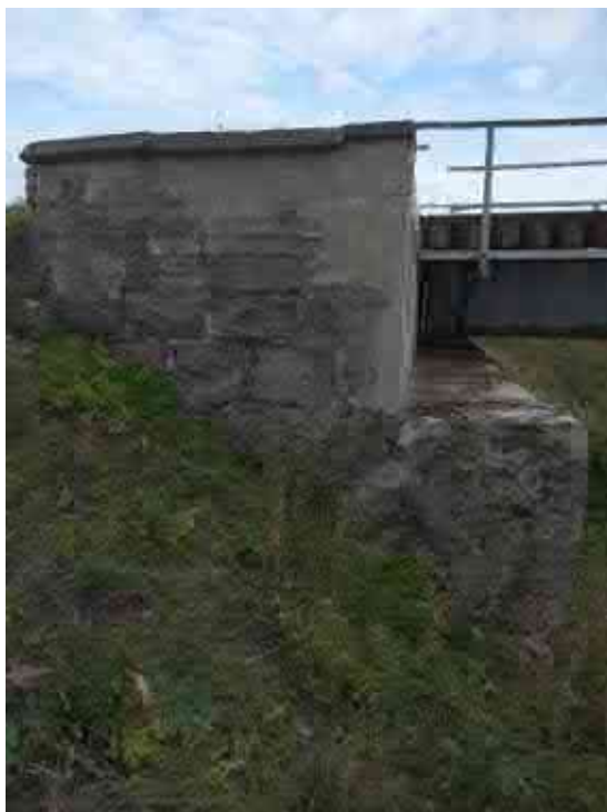
Pav. 9 Ramto sparnai nevienodi, iš skirtingų medžiagų, ištrupėję, kreivi, sutrūkinėję
