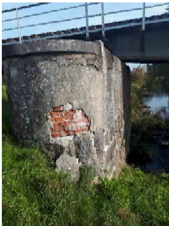
Pav. 5 Taurų betonas porėtas, paviršius nelygus iš aptrupėjęs. Dalies taurų atšokęs mūro tinkas, mūras ištrupėjęs – siūlės ištrupėjęs. Ištrupėjęs granitinių atramų blokų siūlės. Vietomis išvirtę granitiniai blokai
