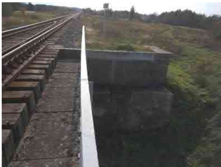
Pav. 10 Užlipti ant sankasos kad tilto apžiūrai atlikti nėra šlaitinių laiptų
