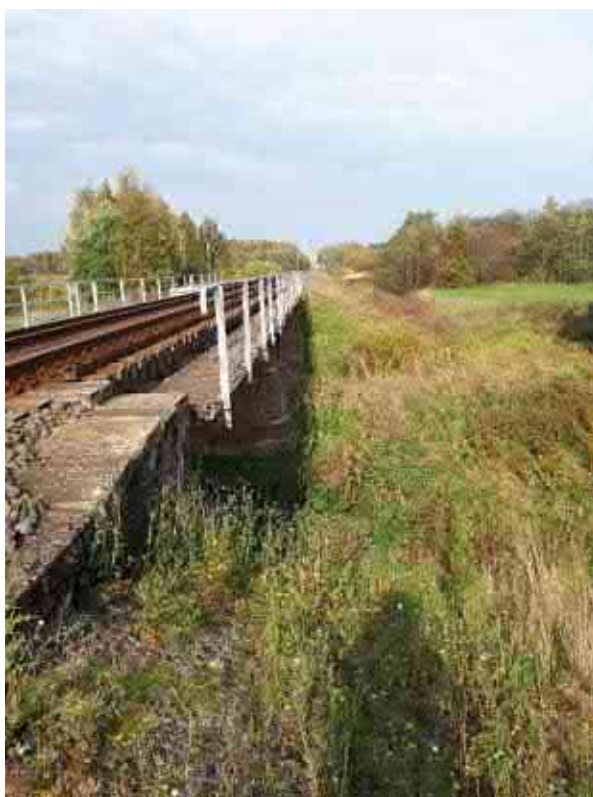
Pav. 12 Sankasos šlaitai tilto prieigose apaugę žole ir piktžolėmis
