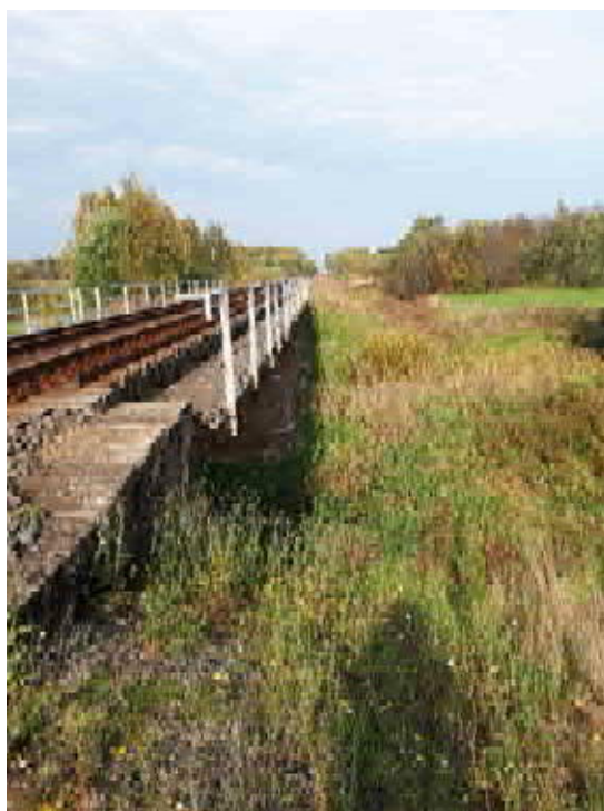
Pav. 10 Sankasos šlaitai tilto prieigose apaugę žole ir piktžolėmis
