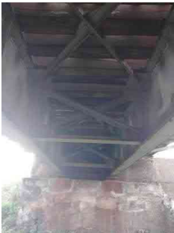
Pav. 6 Perdangos sijos, sijų ryšiai, kniedės ir varžtinės jungtys paveiktos korozijos
