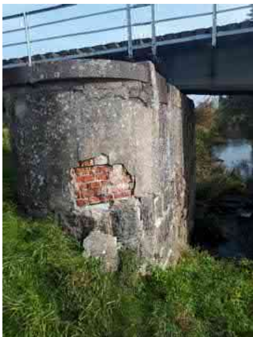
Pav. 7 Taurų betonas porėtas, paviršius nelygus iš aptrupėjęs. Dalies taurų atšokęs mūro tinkas, mūras ištrupėjęs – siūlės ištrupėjusios. Ištrupėjusios granitinių atramų blokų siūlės. Vietomis išvirtę granitiniai blokai
