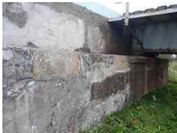
Pav. 8 Ramtų betonas porėtas, paviršius nelygus ir aptrupėjęs. Vietomis sutrūkinėjęs ir atšokęs tinkas
