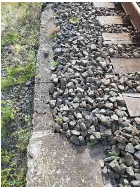
Pav. 13 Tilto prieigose skaldos balastas krenta per sparno bortą
