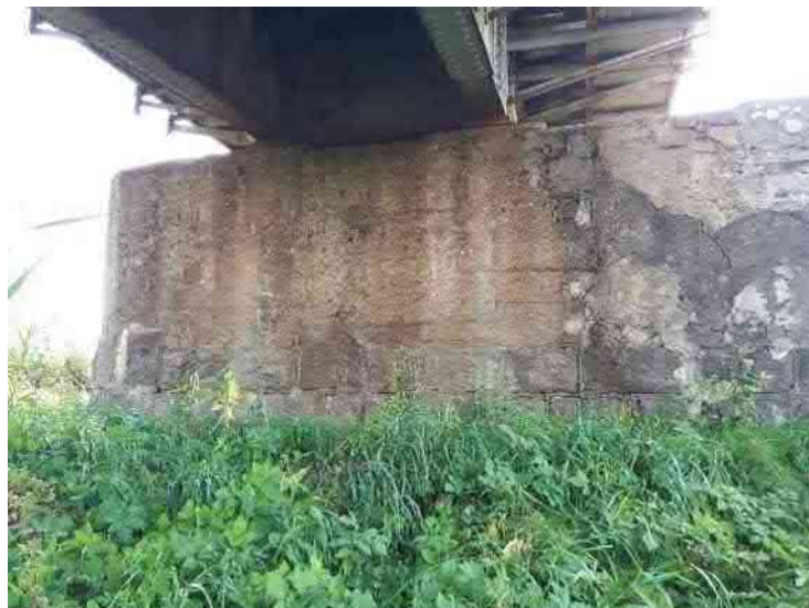
Pav. 5 Taurų betonas porėtas, paviršius nelygus iš aptrupėjęs. Dalies taurų atšokęs mūro tinkas, mūras ištrupėjęs – siūlės ištrupėjęs. Ištrupėjęs granitinių atramų blokų siūlės. Vietomis išvirtę granitiniai blokai
