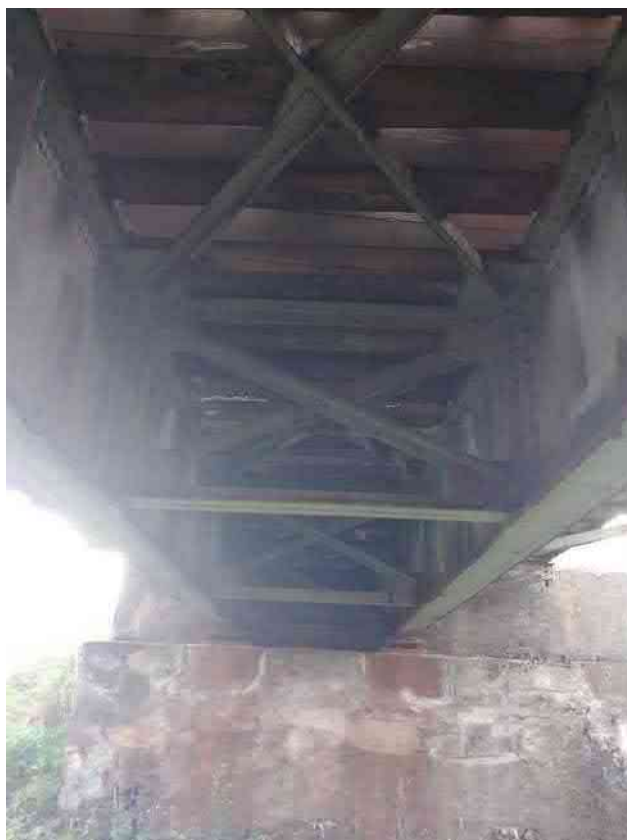
Pav. 4 Perdangos sijos, sijų ryšiai, kniedės ir varžtinės jungtys paveiktos korozijos
