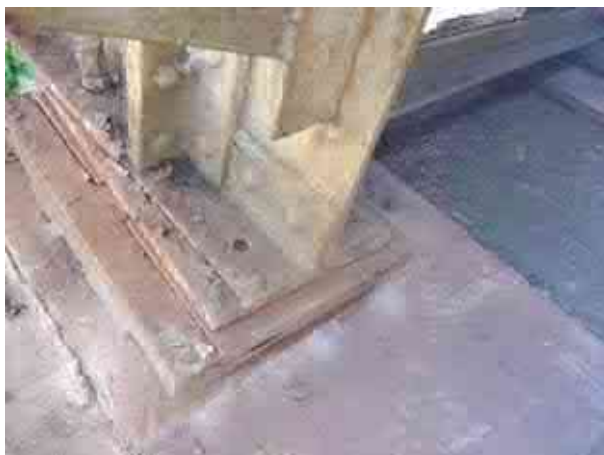
Pav. 5 Sijos virš atraminių guolių labai pažeistos korozijos. Atraminiai guoliai pažeisti korozijos. Atraminių guolių tvirtinimo varžtai surūdiję, vietomis nuovargio ir korozijos pažeisti iškrito
