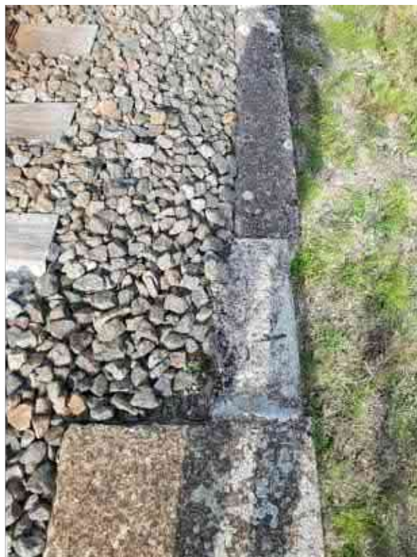
Pav. 13 Tilto prieigose skaldos balastas krenta per sparno bortą
