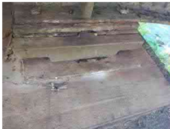
Pav. 5 Sijos virš atraminių guolių labai pažeistos korozijos. Atraminiai guoliai pažeisti korozijos. Atraminių guolių tvirtinimo varžtai surūdiję, vietomis nuovargio ir korozijos pažeisti iškrito
