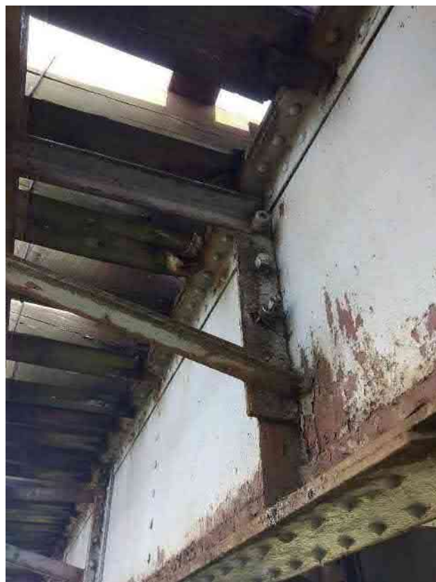
Pav. 4 Perdangos sijos, sijų ryšiai, kniedės ir varžtinės jungtys paveiktos korozijos
