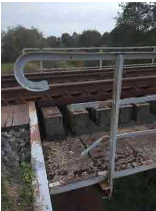
Pav. 3 Turėklai paveikti korozijos. Elementai surūdiję, sulankstyti ir aštriomis briaunomis
