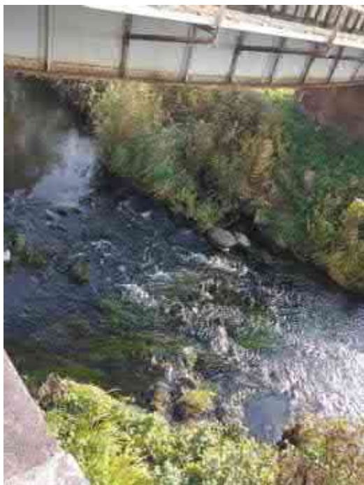
Pav. 11 Upės vaga ir jos šlaitai užversti tilto atramų nuolaužomis (rieduliai, granitiniai blokai). Vagos šlaitai po tilto nelygūs, apaugę žole
