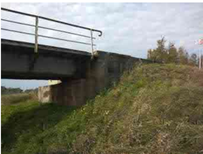
Pav. 9 Ramto sparnai nevienodi, iš skirtingų medžiagų, ištrupėję, kreivi, sutrūkinėję
