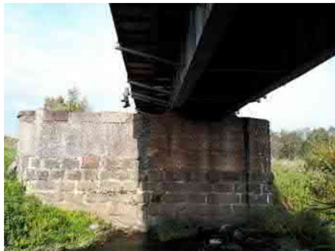
Pav. 11 Upės vaga ir jos šlaitai užversti tilto atramų nuolaužomis (rieduliai, granitiniai blokai). Vagos šlaitai po tilto nelygūs, apaugę žole
