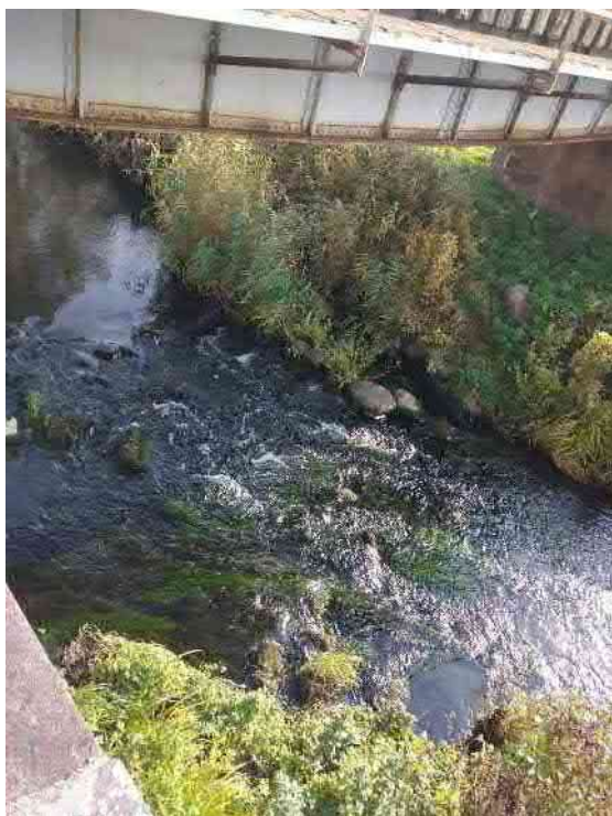
Pav. 9 Upės vaga ir jos šlaitai užversti tilto atramų nuolaužomis (rieduliai, granitiniai blokai). Vagos šlaitai po tilto nelygūs, apaugę žole
