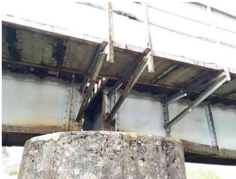
Pav. 2 G/b šalitilčių plokštės sutrūkinėjusios, vietomis ištrupėjęs apsauginis betono sluoksnis. Išilginės sijos, laikančios plokštes, surūdijusios
