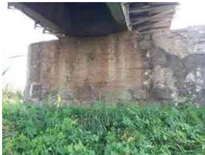
Pav. 7 Taurų betonas porėtas, paviršius nelygus iš aptrupėjęs. Dalies taurų atšokęs mūro tinkas, mūras ištrupėjęs – siūlės ištrupėjusios. Ištrupėjusios granitinių atramų blokų siūlės. Vietomis išvirtę granitiniai blokai
