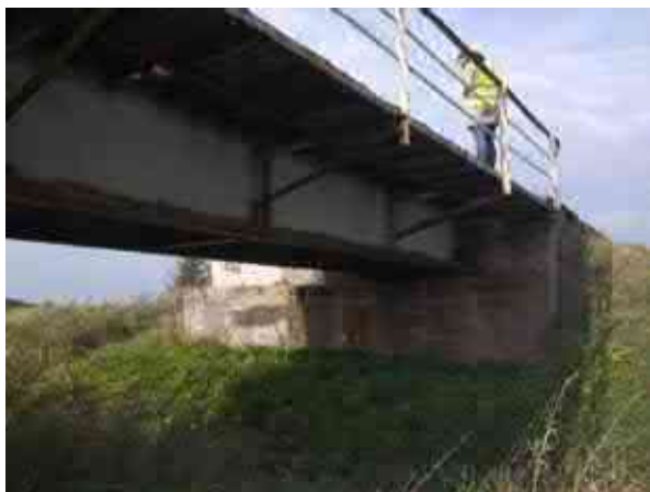
Pav. 8 Ramtų betonas porėtas, paviršius nelygus ir aptrupėjęs. Vietomis sutrūkinėjęs ir atšokęs tinkas
