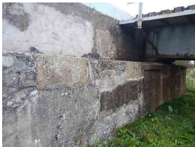
Pav. 6 Ramtų betonas porėtas, paviršius nelygus ir aptrupėjęs. Vietomis sutrūkinėjęs ir atšokęs tinkas
