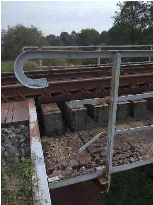
Pav. 1 Turėklai paveikti korozijos. Elementai surūdiję, sulankstyti ir aštriomis briaunomis
