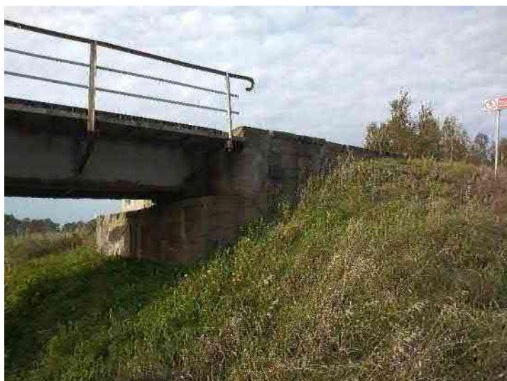
Pav. 7 Ramto sparnai nevienodi, iš skirtingų medžiagų, ištrupėję, kreivi, sutrūkinėję
