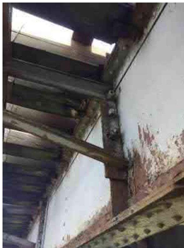
Pav. 6 Perdangos sijos, sijų ryšiai, kniedės ir varžtinės jungtys paveiktos korozijos
