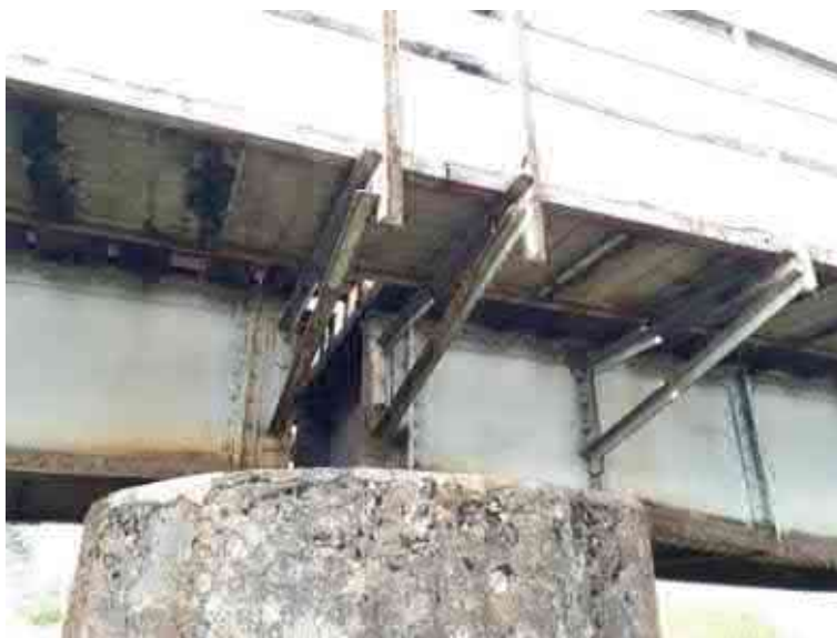
Pav. 4 G/b šalitilčių plokštės sutrūkinėjusios, vietomis ištrupėjęs apsauginis betono sluoksnis. Išilginės sijos, laikančios plokštes, surūdijusios
