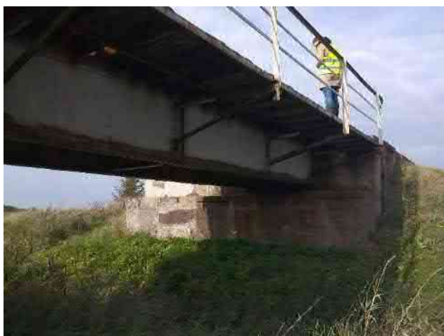
Pav. 6 Ramtų betonas porėtas, paviršius nelygus ir aptrupėjęs. Vietomis sutrūkinėjęs ir atšokęs tinkas
