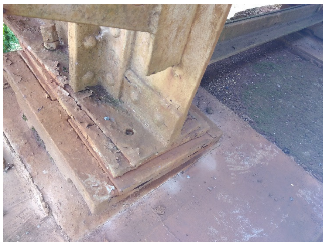
Pav. 3 Sijos virš atraminių guolių labai pažeistos korozijos. Atraminiai guoliai pažeisti korozijos. Atraminių guolių tvirtinimo varžtai surūdiję, vietomis nuovargio ir korozijos pažeisti iškrito
