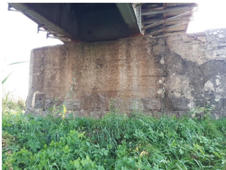
Pav. 5 Taurų betonas porėtas, paviršius nelygus iš aptrupėjęs. Dalies taurų atsokės mūro tinkas, mūras ištrupėjęs – siūlės ištrupėjusios. Ištrupėjusios granitinių atramų blokų siūlės. Vietomis išvirtę granitiniai blokai
