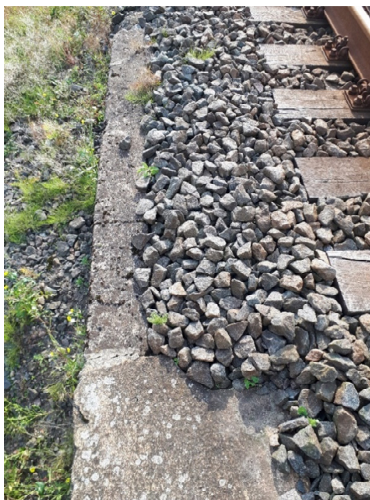
Pav. 11 Tilto prieigose skaldos balastas krenta per sparno bortą
