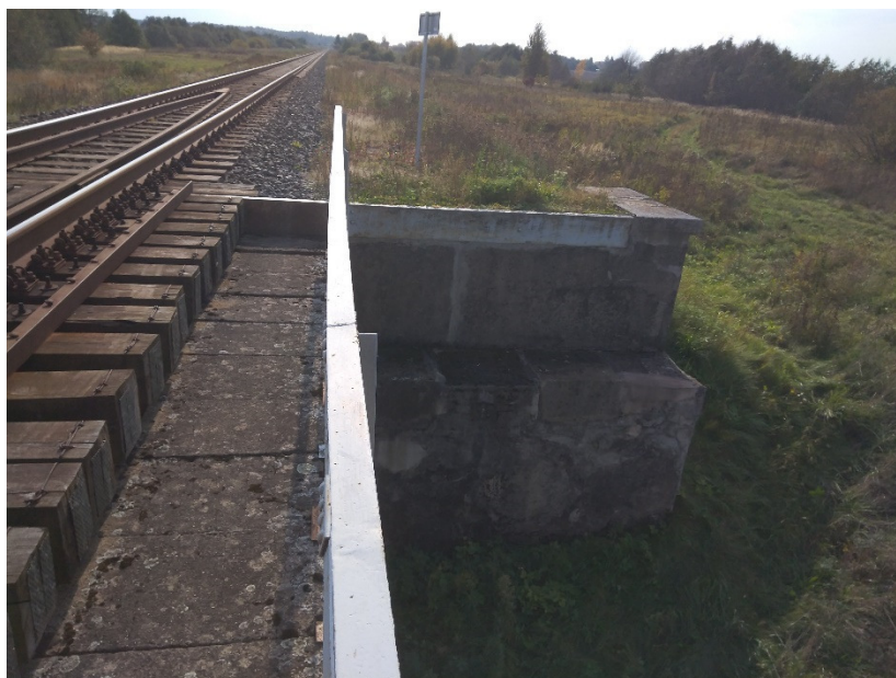
Pav. 8 Užlipti ant sankasos kad tilto apžiūrai atlikti nėra šlaitinių laiptų
