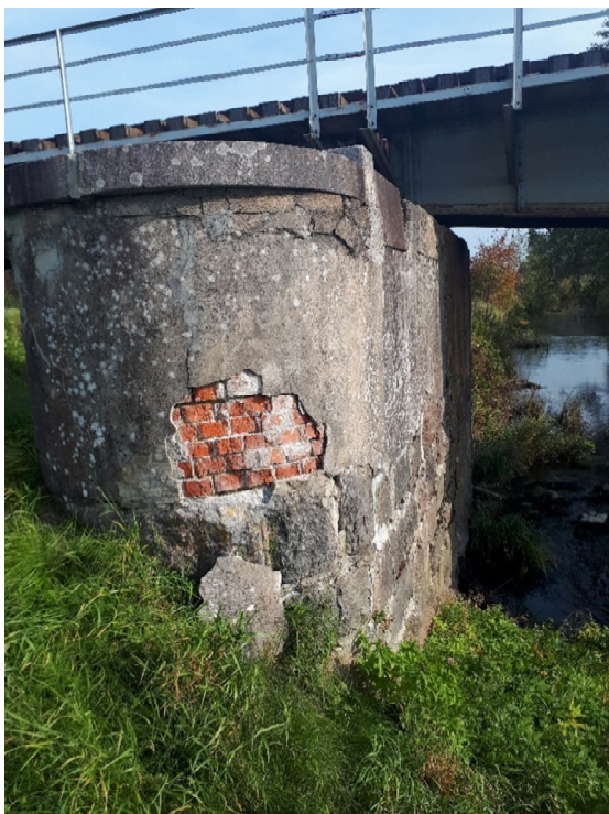
Pav. 5 Taurų betonas porėtas, paviršius nelygus iš aptrupėjęs. Dalies taurų atsokės mūro tinkas, mūras ištrupėjęs – siūlės ištrupėjusios. Ištrupėjusios granitinių atramų blokų siūlės. Vietomis išvirtę granitiniai blokai
