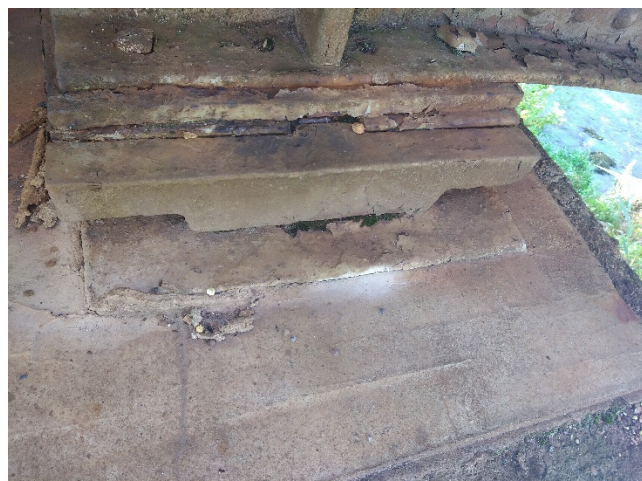
Pav. 3 Sijos virš atraminių guolių labai pažeistos korozijos. Atraminiai guoliai pažeisti korozijos. Atraminių guolių tvirtinimo varžtai surūdiję, vietomis nuovargio ir korozijos pažeisti iškrito
