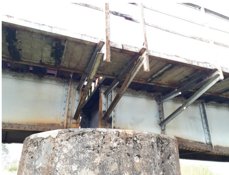
Pav. 2 G/b šaltilių plokštės sutrūkinėjusios, vietomis ištrupėjęs apsauginis betono sluoksnis. Išilginės sijos, laikančios plokštes, surūdijusios
