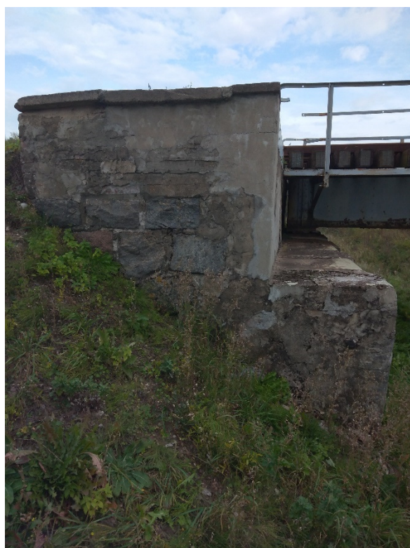
Pav. 7 Ramto sparnai nevienodi, iš skirtingų medžiagų, ištrupėję, kreivi, sutrūkinėję
