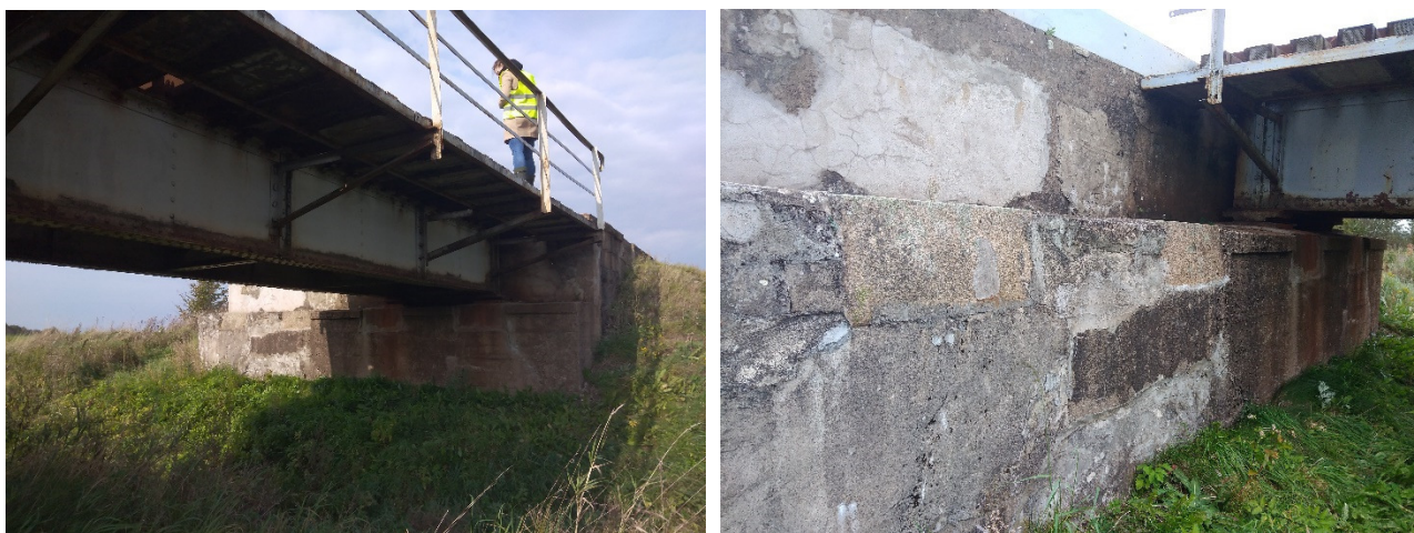
Pav. 6 Ramtų betonas porėtas, paviršius nelygus ir aptrupėjęs. Vietomis sutrūkinėjęs ir atšokęs tinkas
