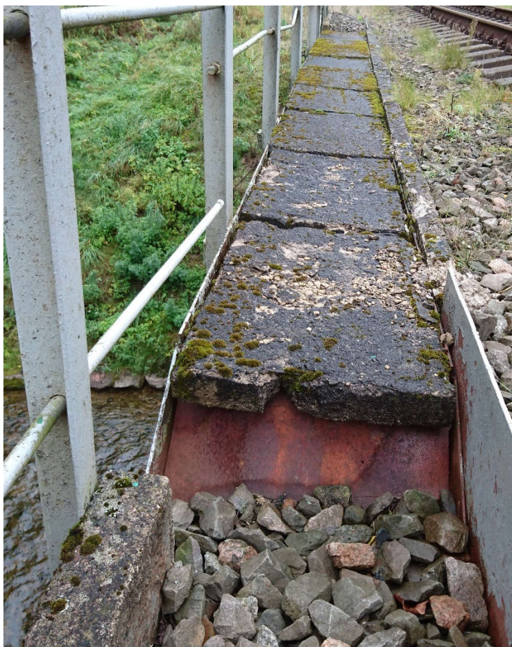
Pav. 6 Šalutė ant tilto ir tilto prieigos neatitinkantys reikalavimų, su nuodaužomis, vakarinėje pusėje tilto prieigos šalutė nėra.
