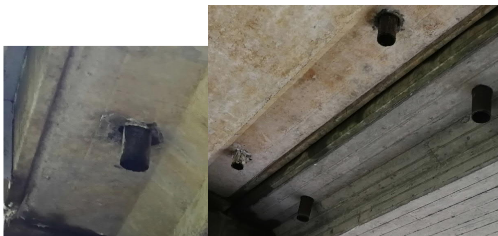
Pav. 5 Nesandarūs vandens nuvedimo šulinėliai.
