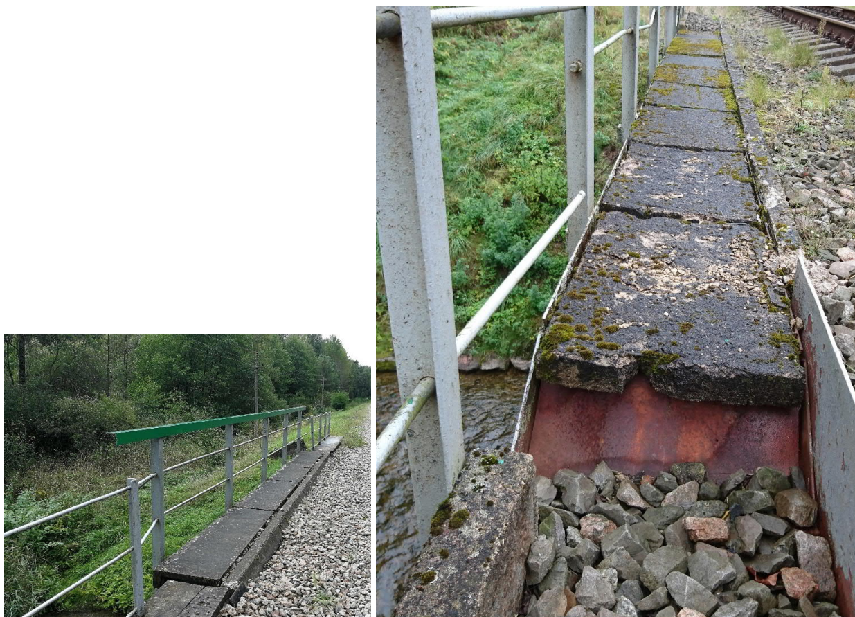
Pav. 6 Šaltilčiai ant tilto ir tilto prieigose neatitinkantys reikalavimų, su nuodaužomis, vakarinėje pusėje tilto prieigose šaltilčių nėra.
