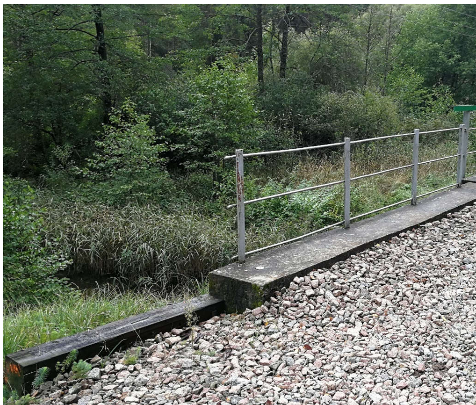
Pav. 8 Tilto prieigos neatitinka reikalavimų nėra pylimo praplatinimo ir atrama per mažai įleista į prietilčio pylimą.
