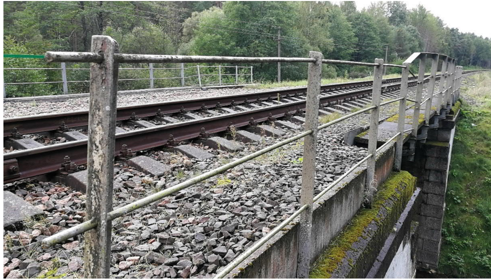
Pav. 3 Turėklai liauni, vietomis išsikraipę, neatitinkantys reikalavimų.
