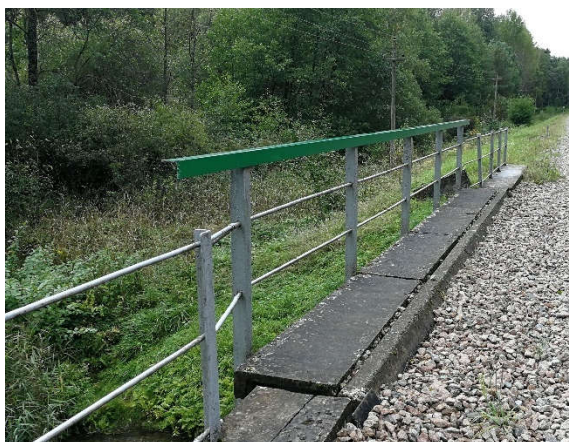
Pav. 6 Šalutė ant tilto ir tilto prieigos neatitinkantys reikalavimų, su nuodaužomis, vakarinėje pusėje tilto prieigos šalutė nėra.
