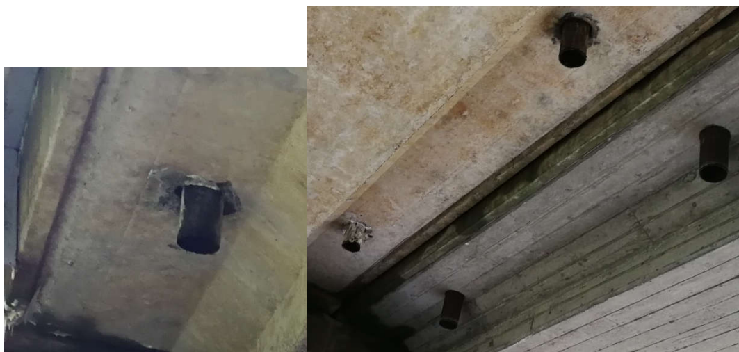
Pav. 5 Nesandarūs vandens nuvedimo šulinėliai.
