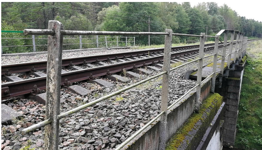
Pav. 3 Turėklai liauni, vietomis išsikraipę, neatitinkantys reikalavimų.
