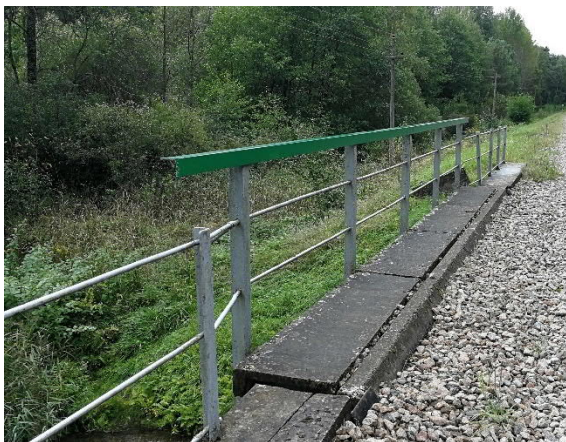
Pav. 6 Šalitulčiai ant tilto ir tilto prieigose neatitinakntys reikalavimų, su nuodaužomis, vakarinėje pusėje tilto prieigose šalitulčių nėra.
