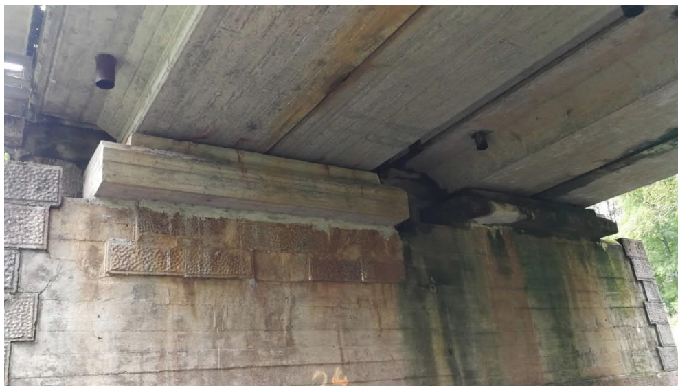
Pav. 4 Nesandarūs tiek išilginis, tiek skersinis deformacinis pjūvis.
