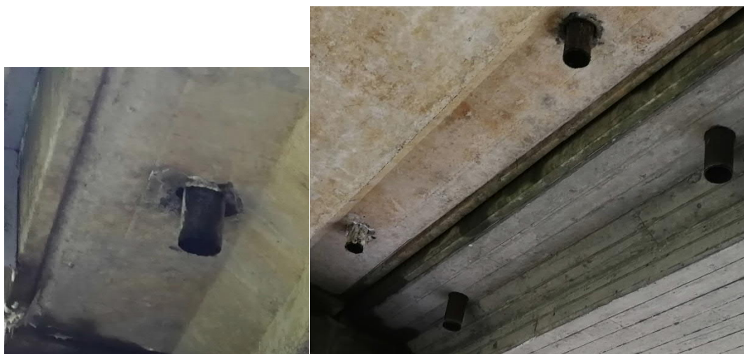
Pav. 5 Nesandarūs vandens nuvedimo šulinėliai.
