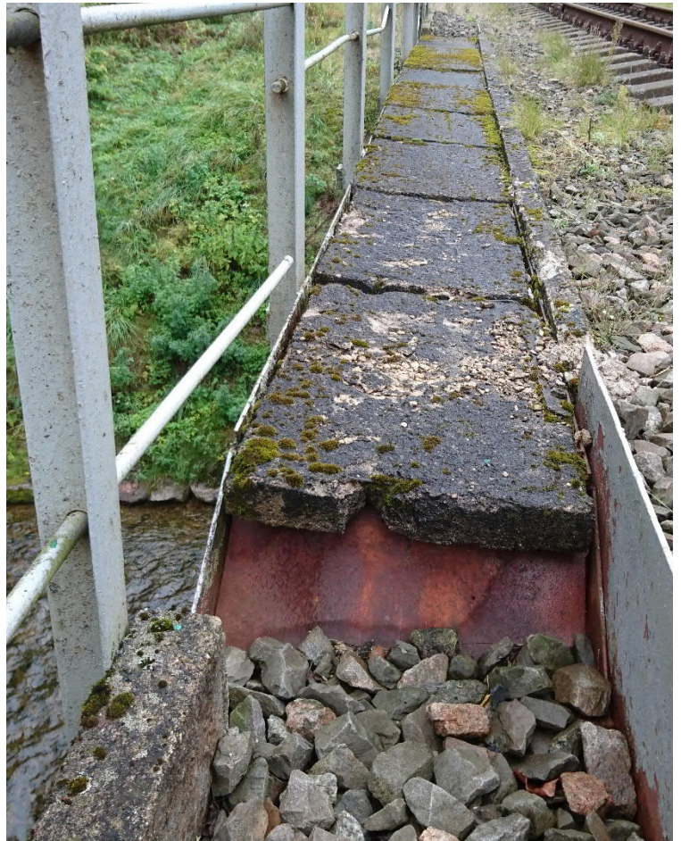
Pav. 6 Šalitulčiai ant tilto ir tilto prieigose neatitinakntys reikalavimų, su nuodaužomis, vakarinėje pusėje tilto prieigose šalitulčių nėra.
