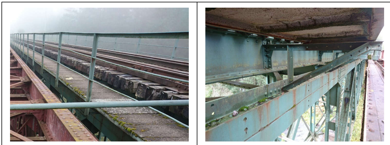
Pav. 8 Šaltilčiai ir turėklai. Pažeisti korozijos, apaugę kerpėmis, sulankstyti. Vaikstant juntami žymūs šaltilčio konstrukcijos svyravimai. Tako gelžbetoninių plytelių apsauginis betono sluoksnis ištrupėjęs, matosi koroduojanti armatūra. Plytelės apaugusios kerpėmis
