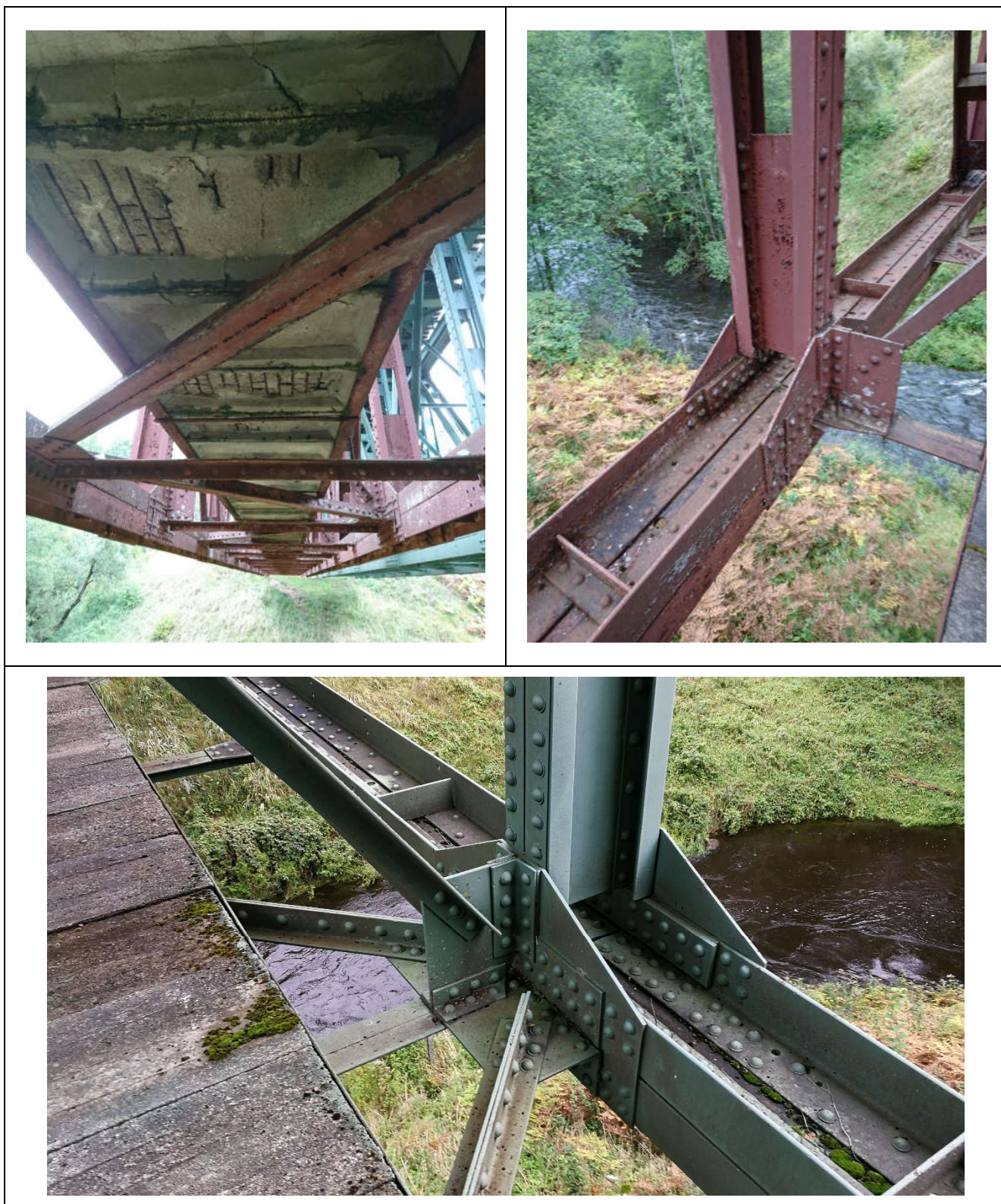
Pav. 6 Perdanga. Dažai atšokę, pažeista korozijos, apaugusi kerpėmis. Apatinio tako gelžbetoninių plytelių apsauginis betono sluoksnis ištrupėjęs, matosi koroduojanti armatūra. Plytelės apaugusios kerpėmis.
