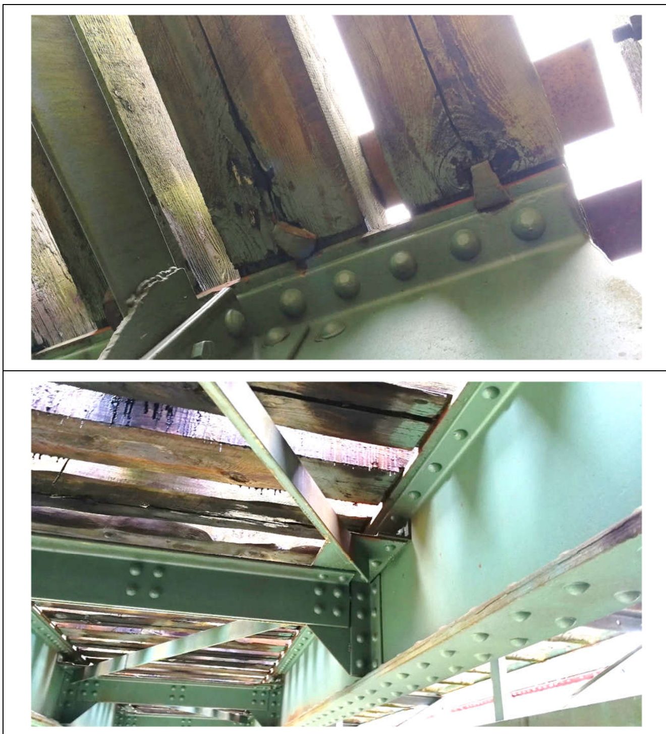
Pav. 7 Pabėgiai. Pažeisti puvinio, suskilę.
