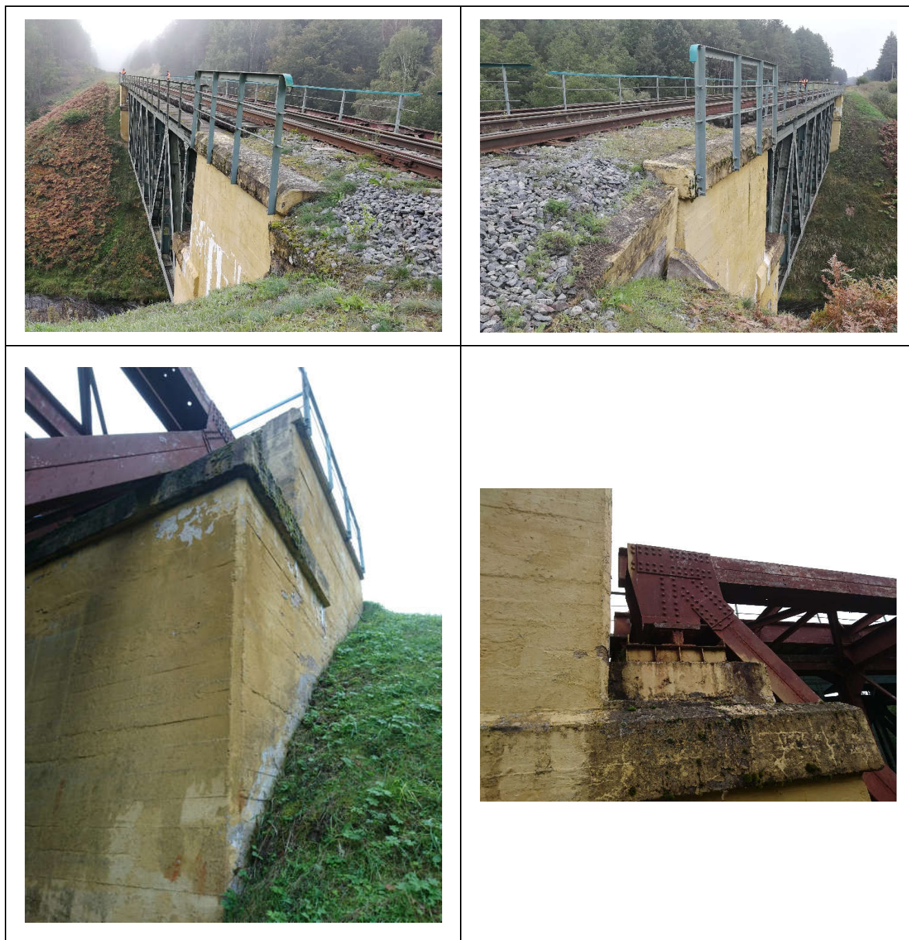
Pav. 4 Atramos. Dažai ir tinkas atšokę, apaugusios kerpėmis, nuskilinėję kampai. Už atramų esančios atraminės sienos įrengtos per žemos ir per trumpos, nuslinkusios į šoną.
