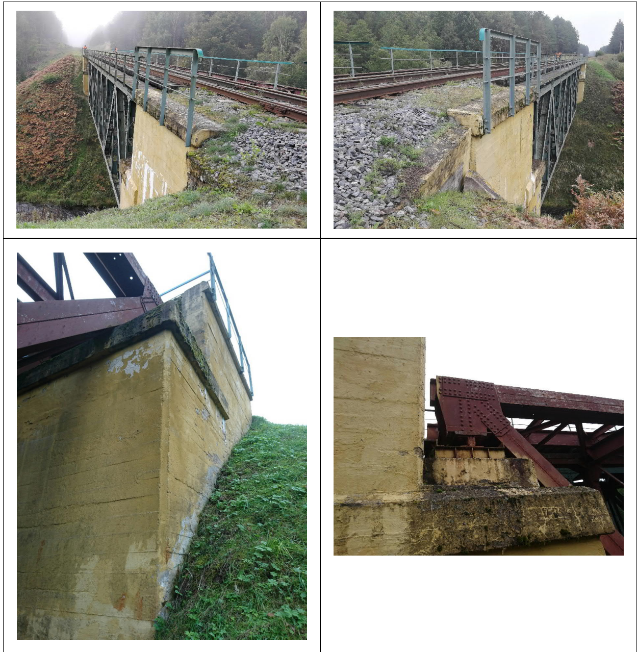
Pav. 4 Atramos. Dažai ir tinkas atšokę, apaugusios kerpėmis, nuskilinėję kampai. Už atramų esančios atraminės sienos įrengtos per žemos ir per trumpos, nuslinkusios į šoną.
