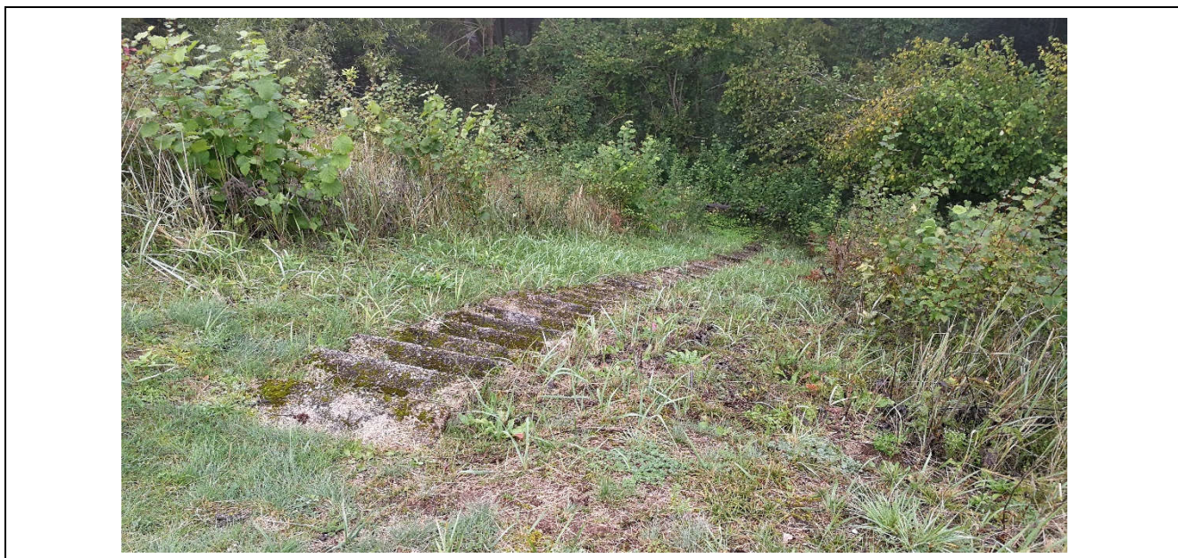
Pav. 9 Šlaitiniai. Šlaitiniai laiptai suirę, nėra turėklų.
