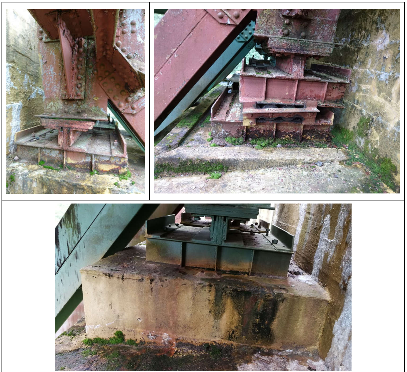
Pav. 5 Atraminiai guoliai. Dažai atšokę, pažeisti korozijos, apaugę kerpėmis
