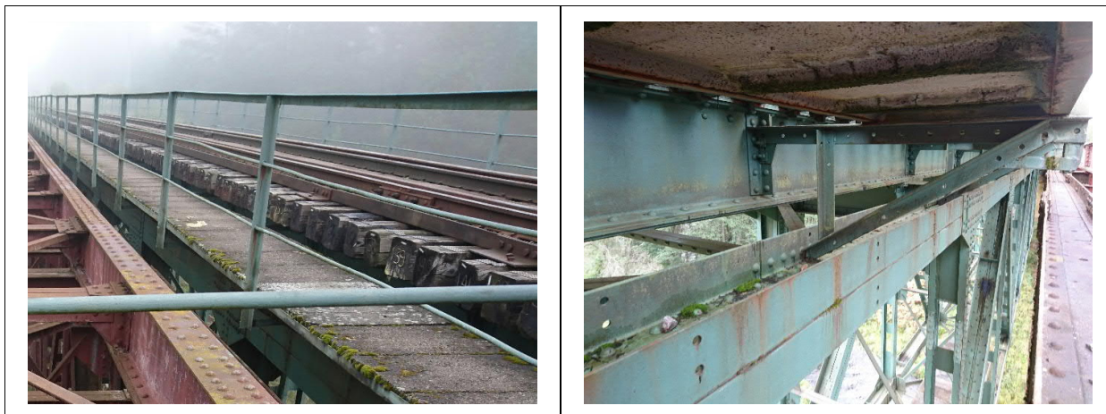
Pav. 8 Šalitulčiai ir turėklai. Pažeisti korozijos, apaugę kerpėmis, sulankstyti. Vaikstant juntami žymūs šalitulčio konstrukcijos svyravimai. Tako gelžbetoninių plytelių apsauginis betono sluoksnis ištrupėjęs, matosi koroduojanti armatūra. Plytelės apaugusios kerpėmis
