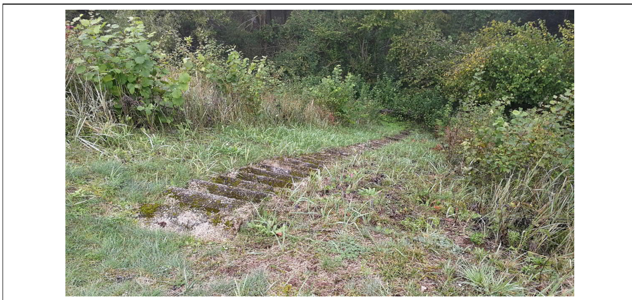
Pav. 9 Šlaitiniai. Šlaitiniai laiptai suirę, nėra turėklų.
