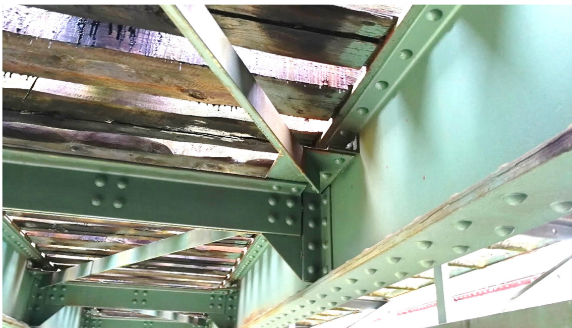
Pav. 7 Pabėgiai. Pažeisti puvinio, suskilę.
