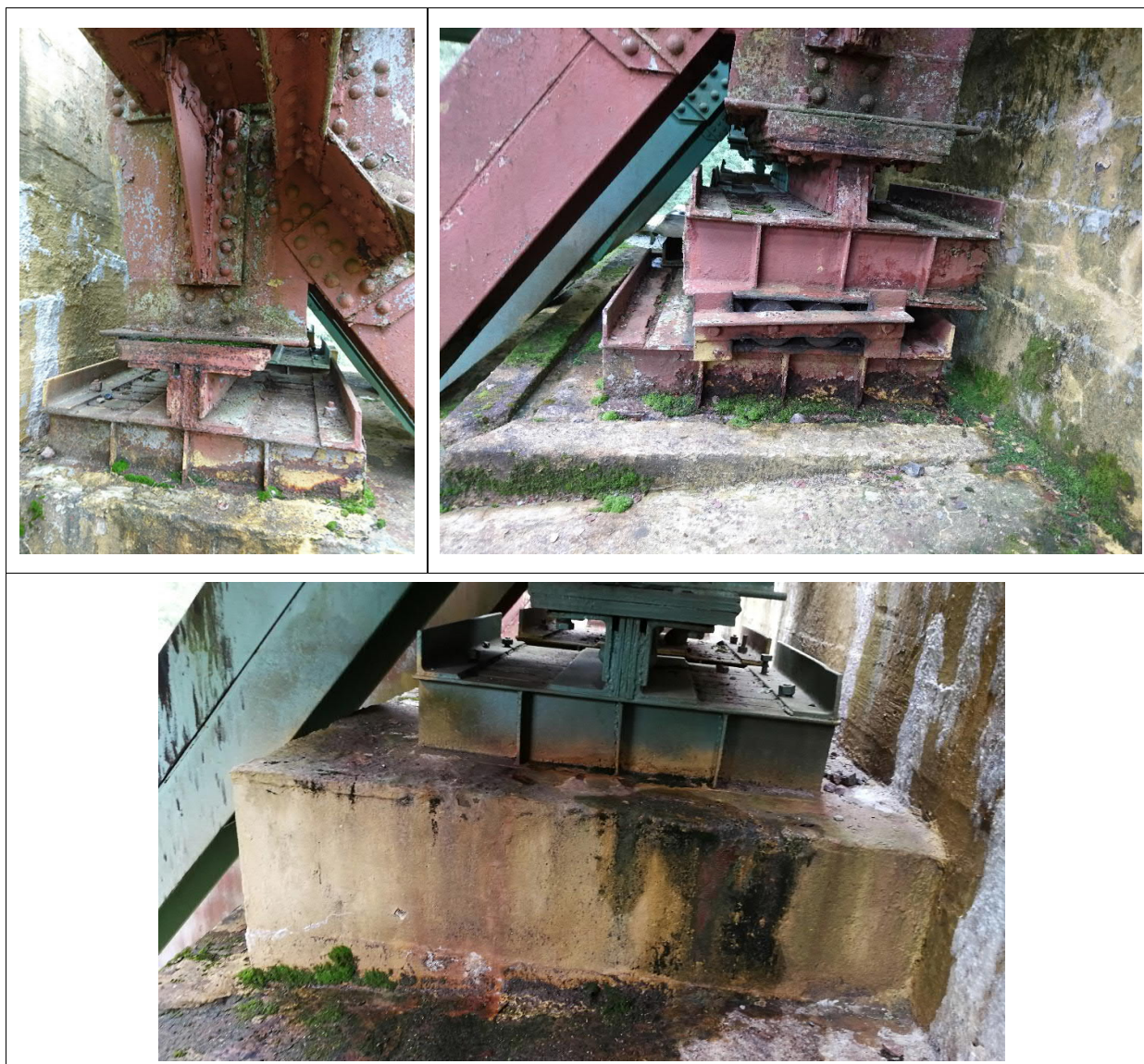
Pav. 5 Atraminiai guoliai. Dažai atšokę, pažeisti korozijos, apaugę kerpėmis
