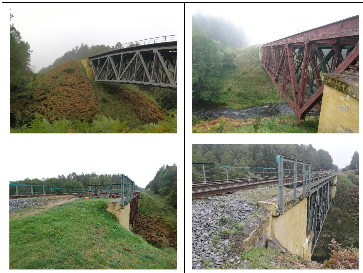
Pav. 3 Kūgių šlaitai. Viršutinė dalis (ties sparnais) išplauta vandens arba nuslinkusi.
