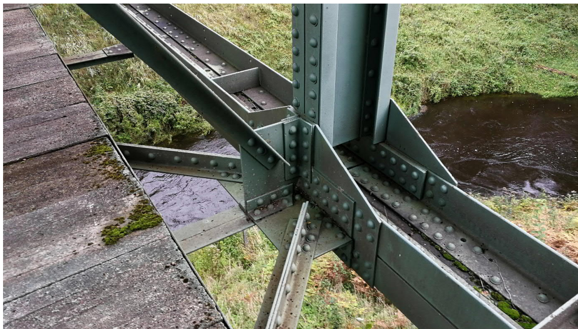
Pav. 6 Perdanga. Dažai atšokę, pažeista korozijos, apaugusi kerpėmis. Apatinio tako gelžbetoninių plytelių apsauginis betono sluoksnis ištrupėjęs, matosi koroduojanti armatūra. Plytelės apaugusios kerpėmis.
