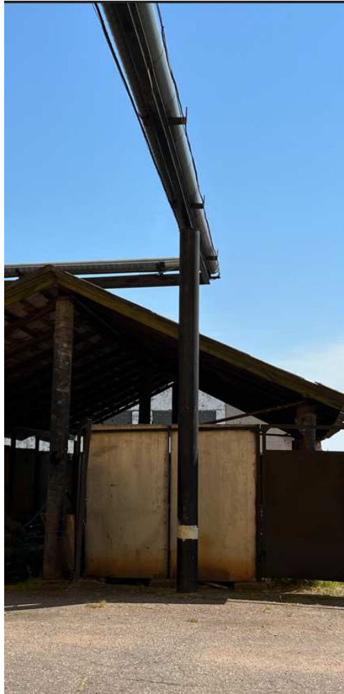
1 pav. Esamos estakados konstrukcijos.
