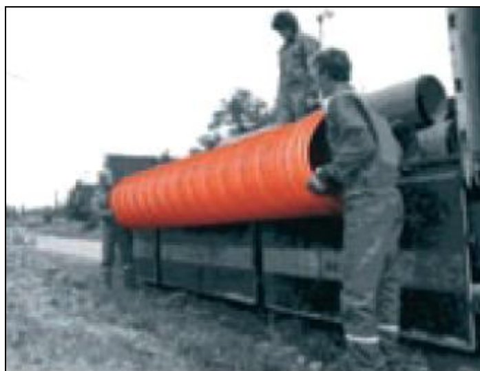
3 pav. Vamzdžių krovos darbai
