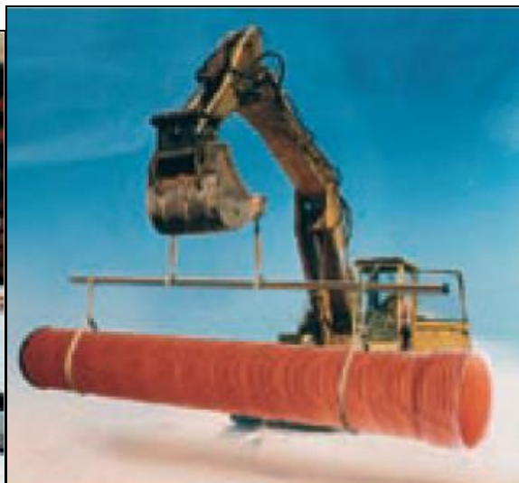
2 pav. Mechanizuotas vamzdžių krovimas
