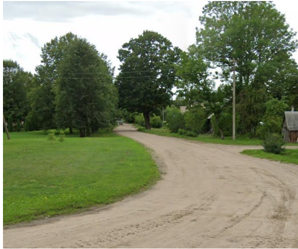
1 pav. Esamos gatvės būklės fotografacija
