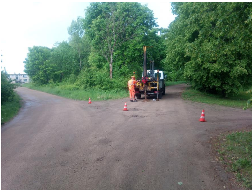
1 pav. Lauko darbai
