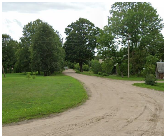
1 pav. Esamos gatvės būklės fotofiksacija
