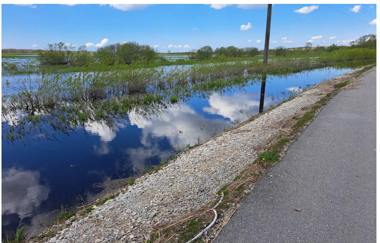
12 pav. Kelio Nr. 4216 antras ruožas nuo 4,860 iki 5,30 km. Dešinėje kelio pusėje paplauta kelio sankasa, kelkraščiuose matyti žolių ir šakų sankaupos
