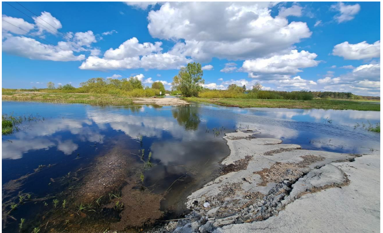
7 pav. Kelias Nr. 4216 pirmas ruožas nuo 4,767 iki 4,860 km. Suardyta ir nuplauta kelio dangos konstrukcija, nuplauta kelio sankasa, bendras kelio vaizdas žiūrint iš dešinės kelio pusės. Apie 93 m kelio yra po vandeniu, aplinkui matyti patvenktos pievos ir dirbami laukai
