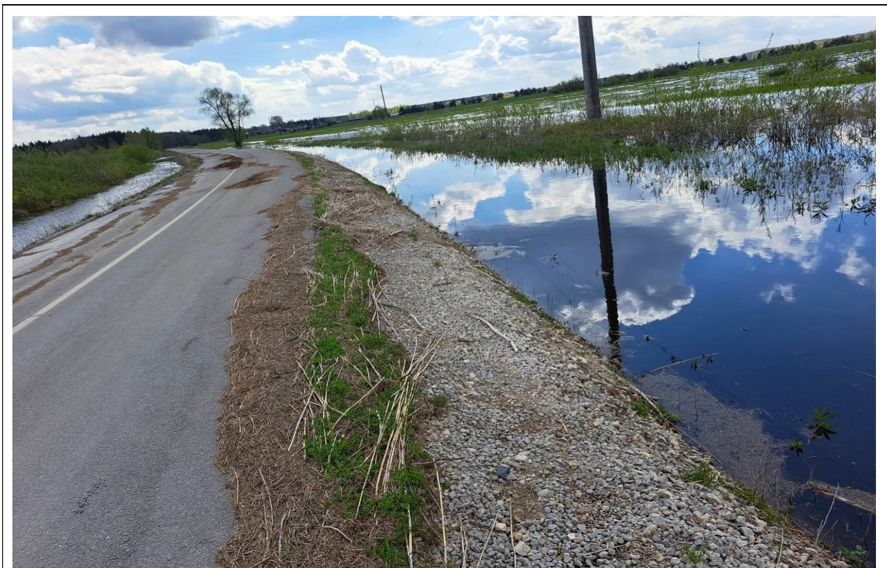
9 pav. Kelio Nr. 4216 antras ruožas nuo 4,860 iki 5,30 km. Kairėje kelio pusėje pažeistas sankasos šlaito sutvirtinimas
