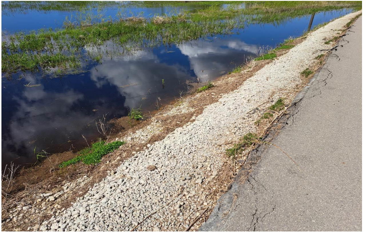
15 pav. Kelio Nr. 4216 antras ruožas nuo 4,860 iki 5,30 km. Dešinėje kelio pusėje paplauta kelio sankasa, pažeistas kelkraštis, palei kraštą atitrūkusi ir atlūžusi asfaltbetonio danga
