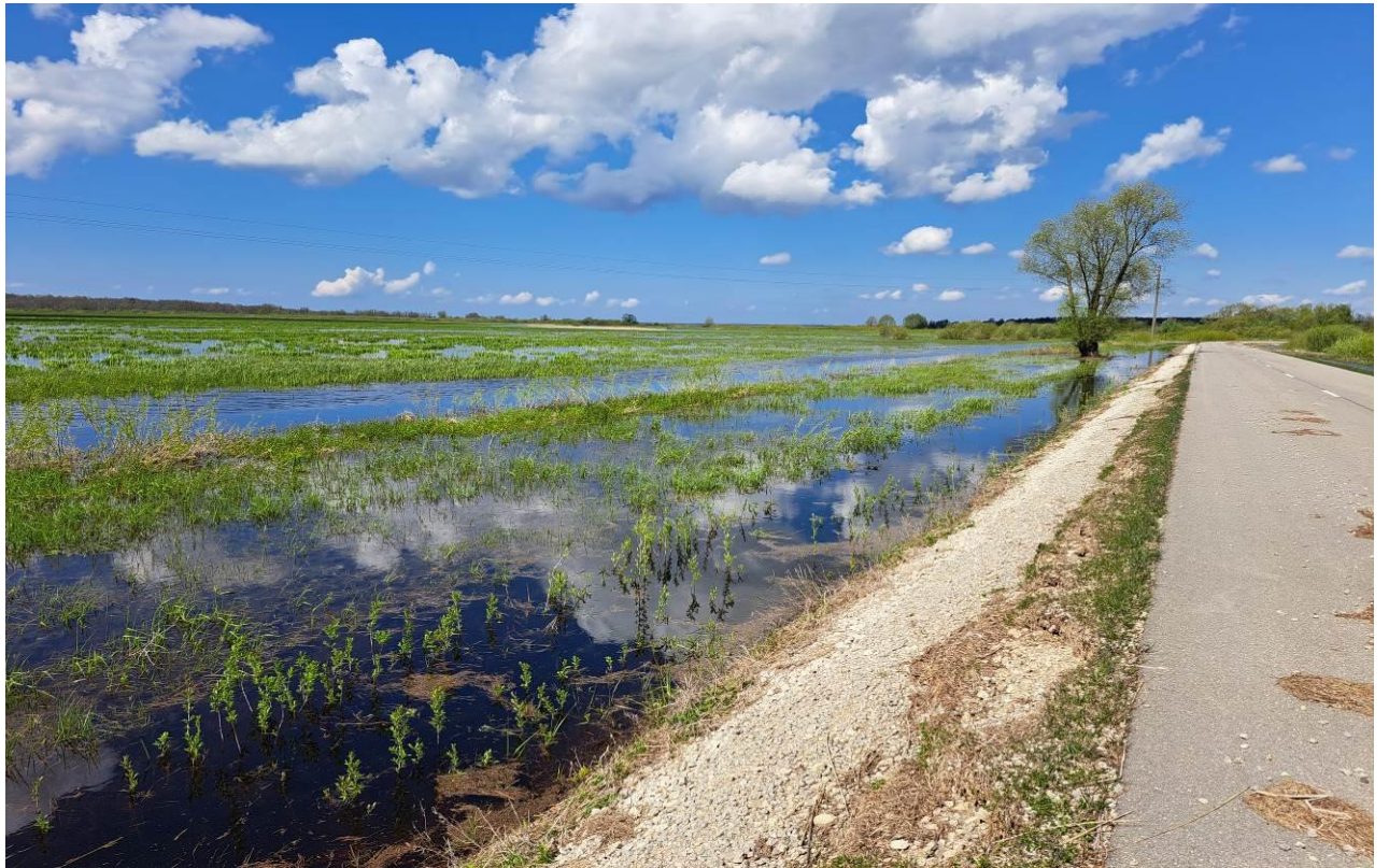
25 pav. Kelio Nr. 4216 trečias ruožas nuo 5,30 iki 5,46 km. Dešinėje kelio pusėje, paplautas kelio sankasos šlaitas
