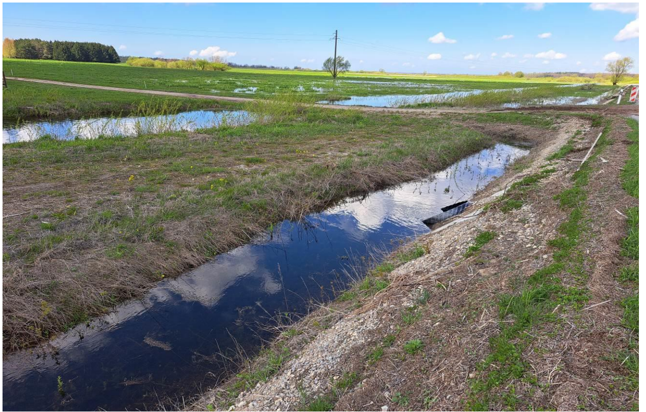
31 pav. Kelio Nr. 4216 trečias ruožas nuo 5,30 iki 5,46 km. Dešinėje kelio pusėje nuo piketo Pk 53+96 iki piketo Pk 53+00 minimaliai paplautas kelio sankasos šlaito sutvirtinimas, kelio dangoje pažeidimų nėra
