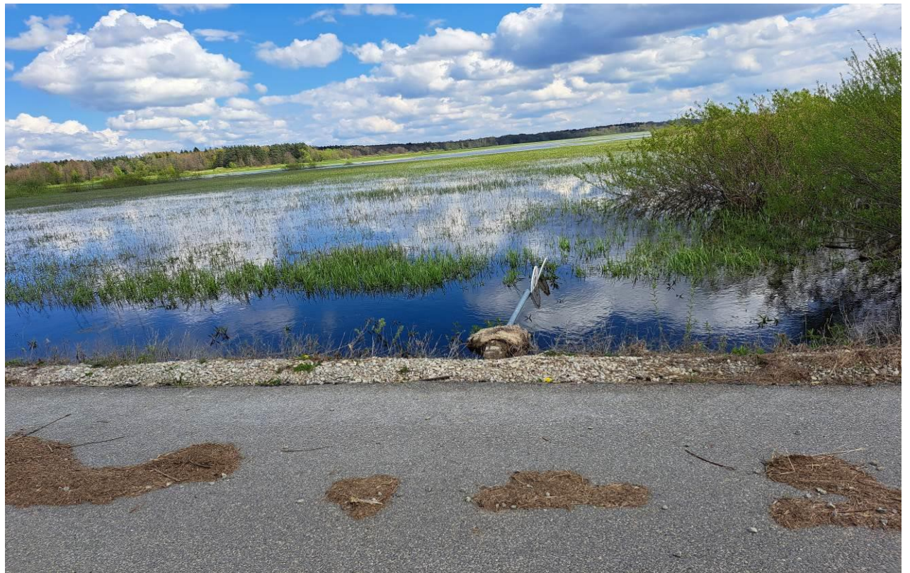
19 pav. Kelio Nr. 4216 antras ruožas nuo 4,860 iki 5,30 km. Kairėje kelio pusėje, ties piketu Pk 49+74 nuvirtusi atrama su kelio ženklais Nr. 325 ir Nr. 329. Taip pat, kairėje kelio pusėje paplautas kelio sankasos šlaitas
