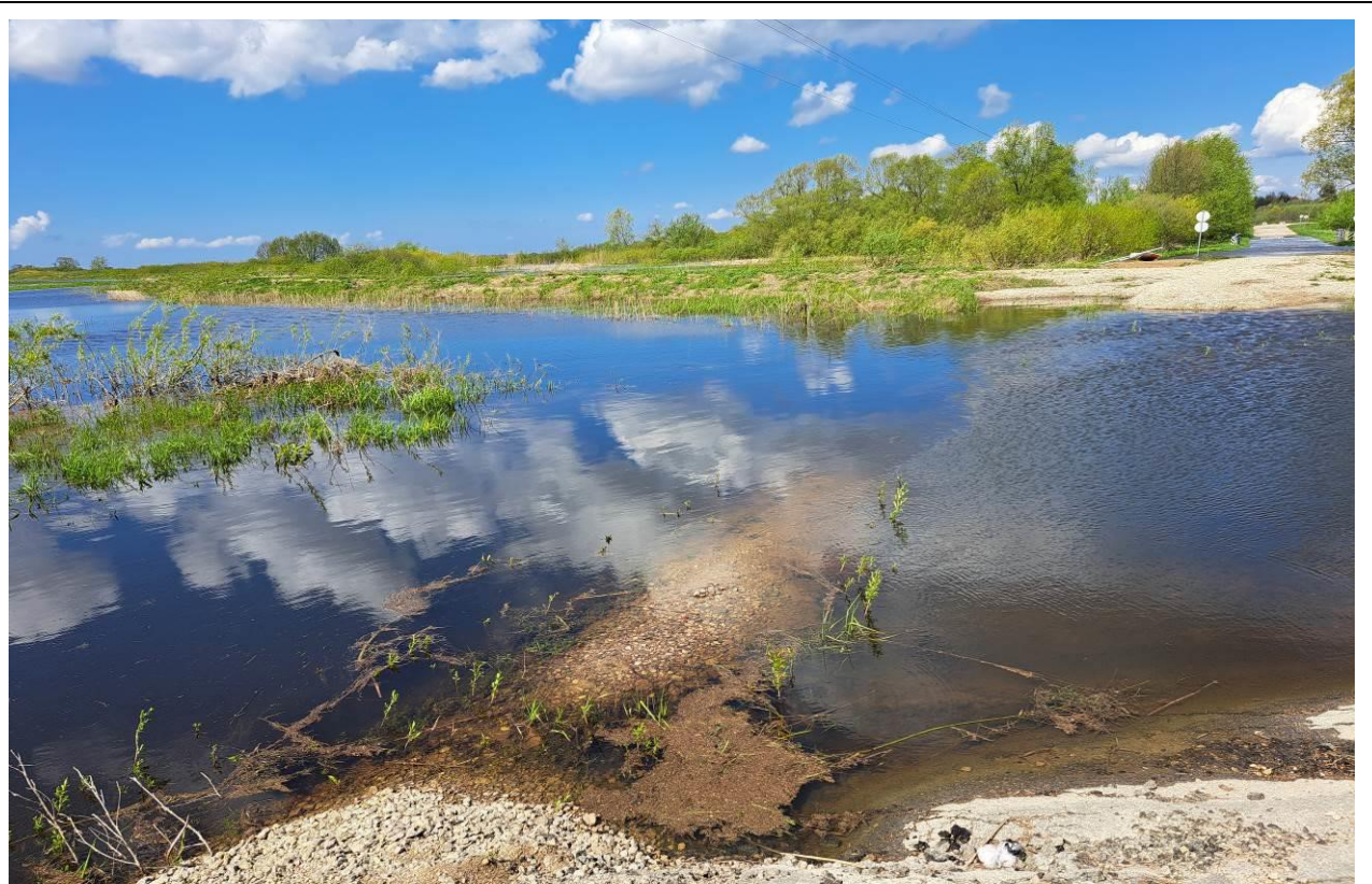
8 pav. Kelias Nr. 4216 pirmas ruožas nuo 4,767 iki 4,860 km. Suardyta ir nuplauta kelio dangos konstrukcija, nuplauta kelio sankasa, bendras kelio vaizdas žiūrint iš kairės kelio pusės į Nemuno upės pusę. Aplinkui matyti patvenktos pievos
