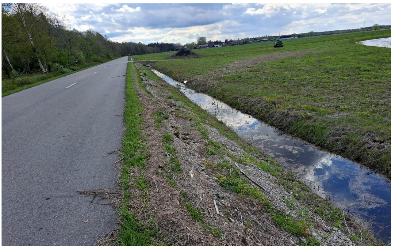
32 pav. Kelio Nr. 4216 trečias ruožas nuo 5,30 iki 5,46 km. Dešinėje kelio pusėje minimaliai paplautas kelio sankasos šlaito sutvirtinimas
