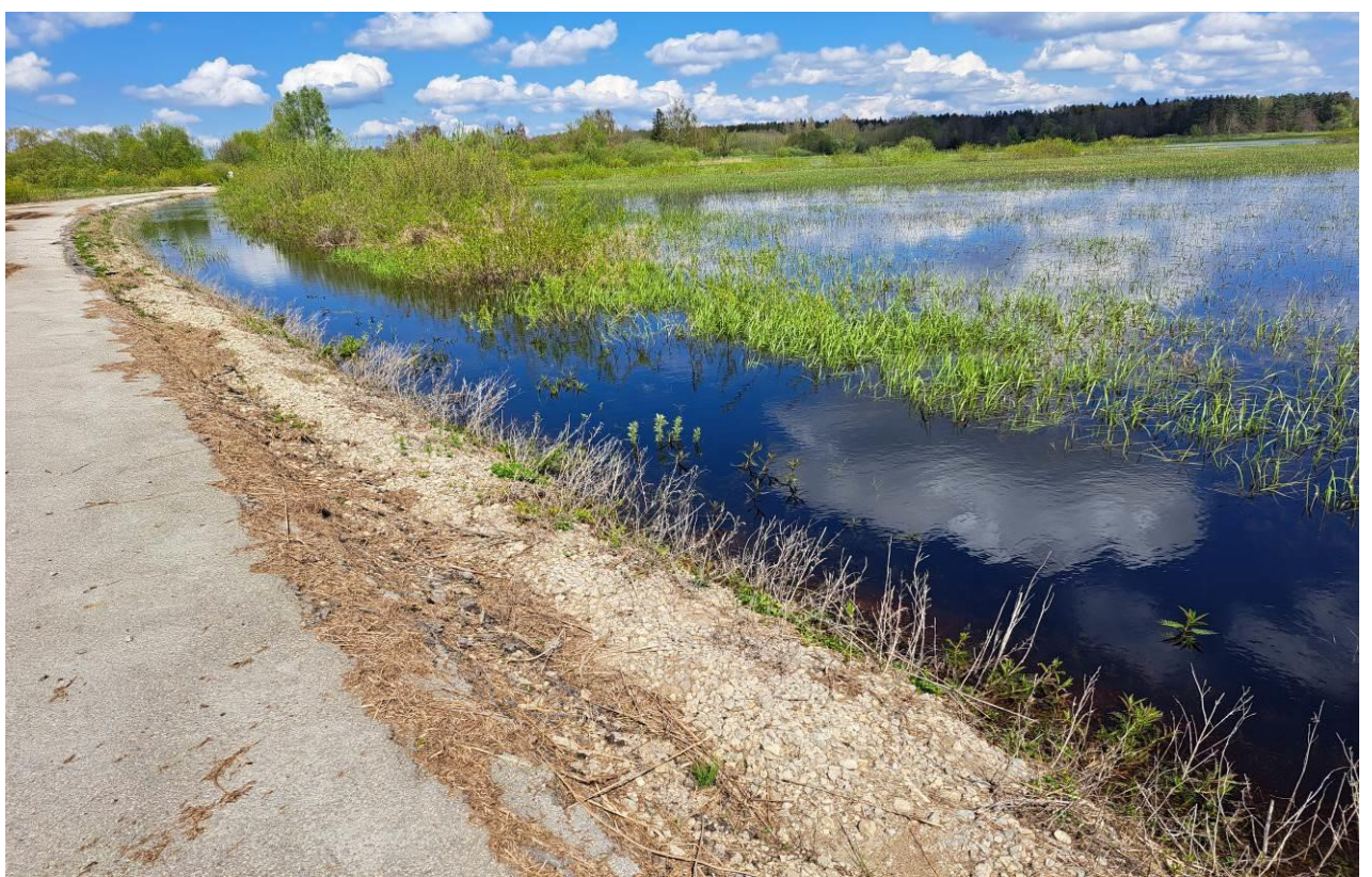
16 pav. Kelio Nr. 4216 antras ruožas nuo 4,860 iki 5,30 km. Kairėje kelio pusėje paplauta kelio sankasa, pažeistas kelkraštis, palei kraštą susikaupę žolės ir žemės
