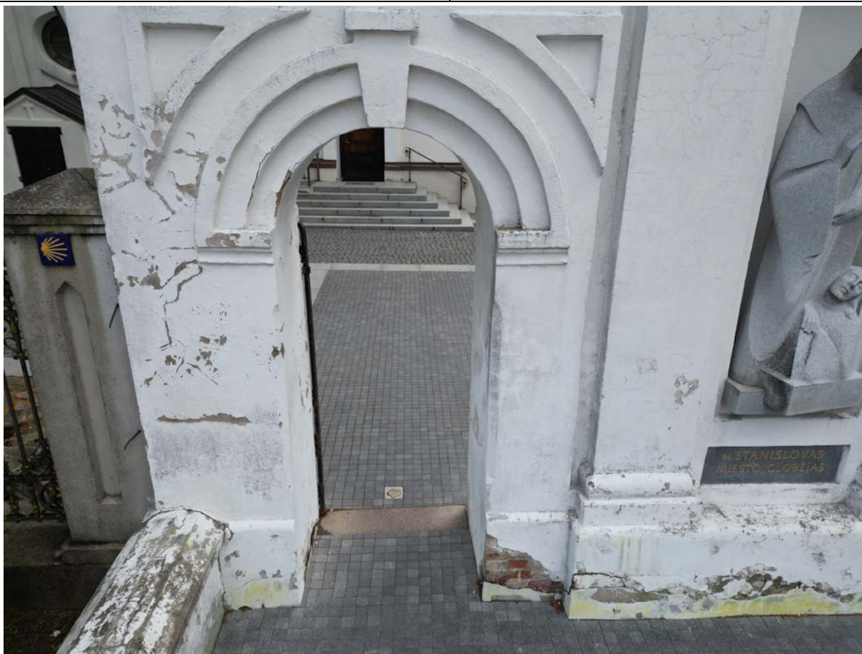
Vaizdas iš V pusės. Centrinės vartų dalies fragmentas iš kairės su šonine įėjimo anga.
