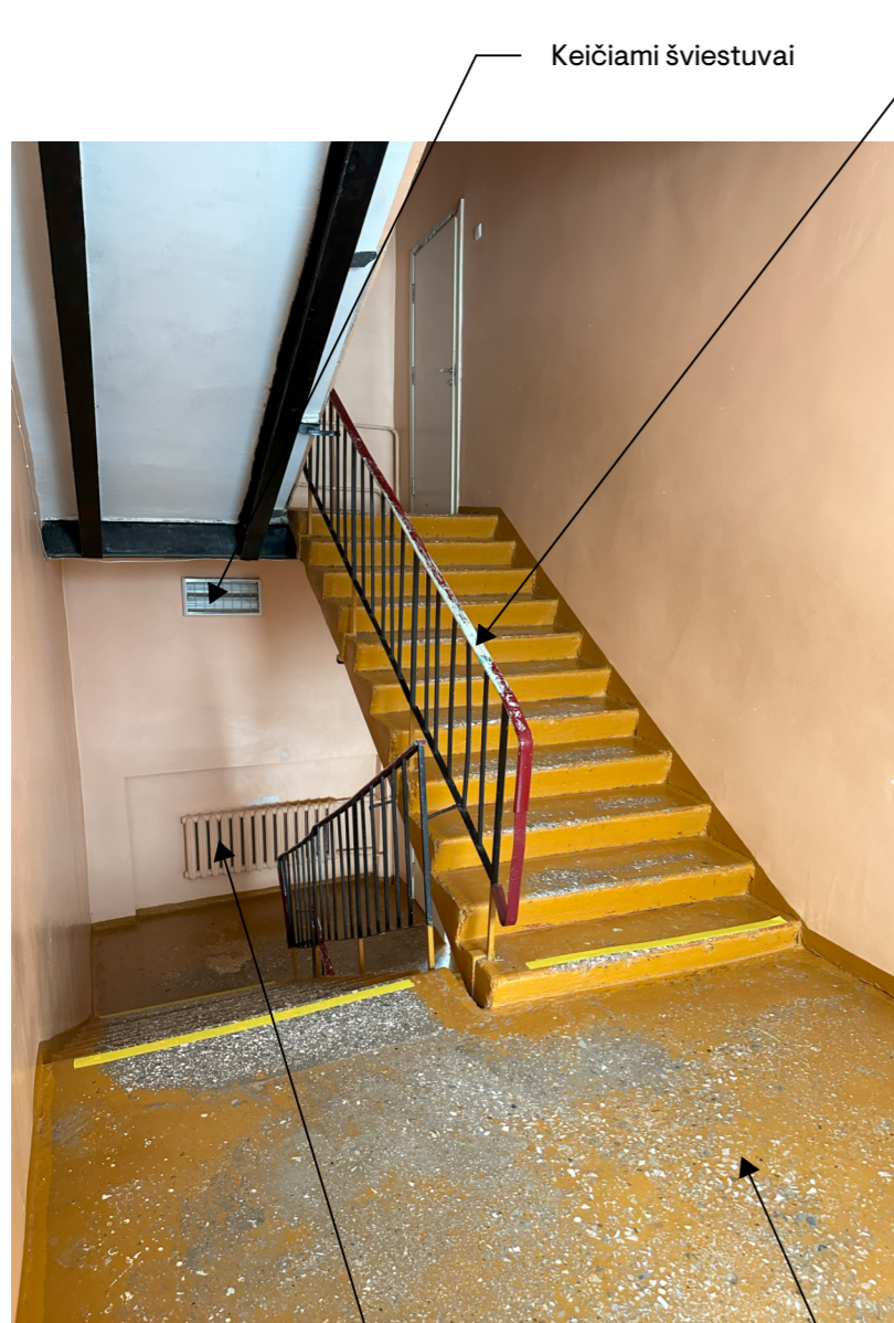
Įrengiamos apsauginės tvorelės, pritaikant prie esamo ŽN keltuvo konstrukcijos rėmo
