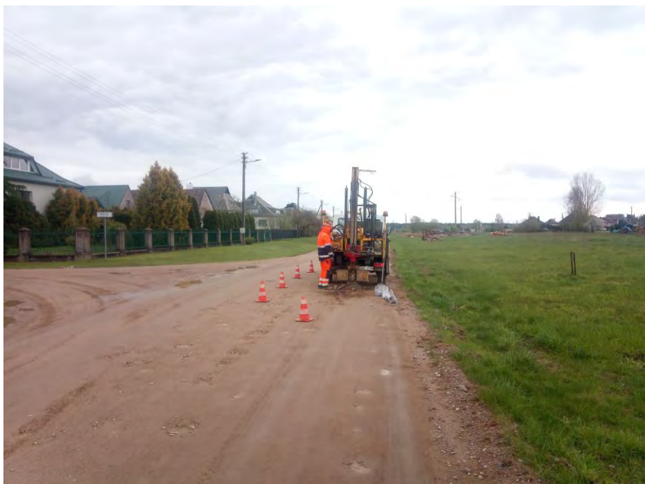
1 pav. Lauko darbai
