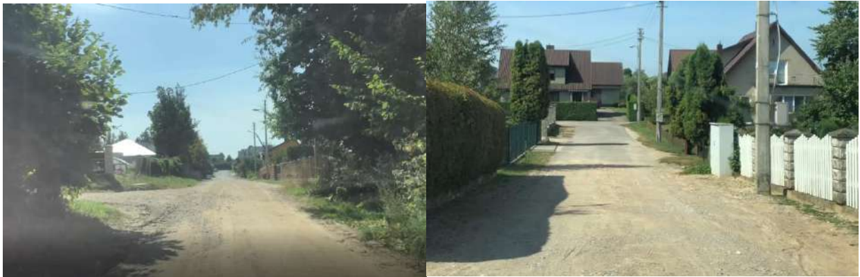
1 pav. Esamų gatvių būklės fotografacija
