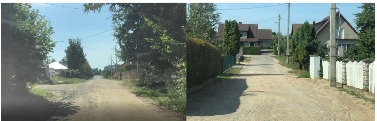
2 pav. Esamų gatvių būklės fotografacija
