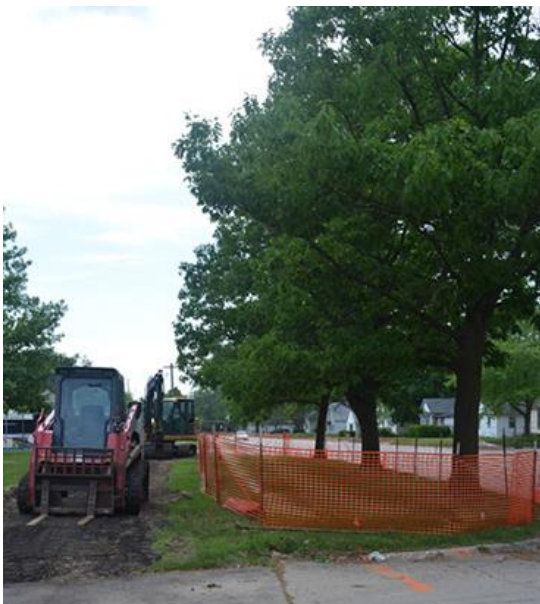
Pav. 1. Aptvaru atitverta šaknų apsaugos zona statybų metu.
