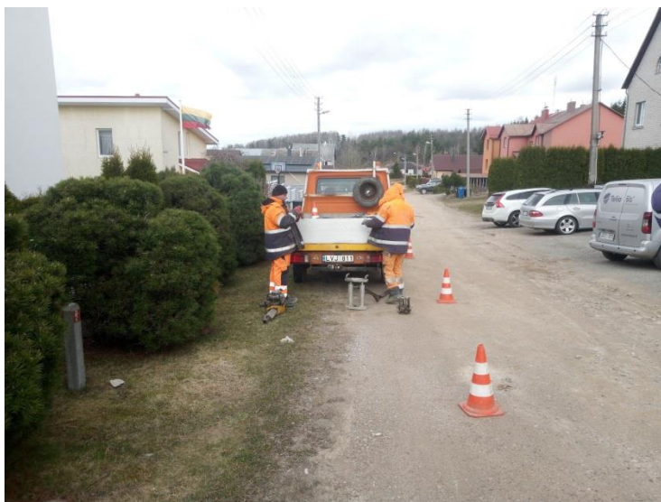
1 pav. Lauko darbai
