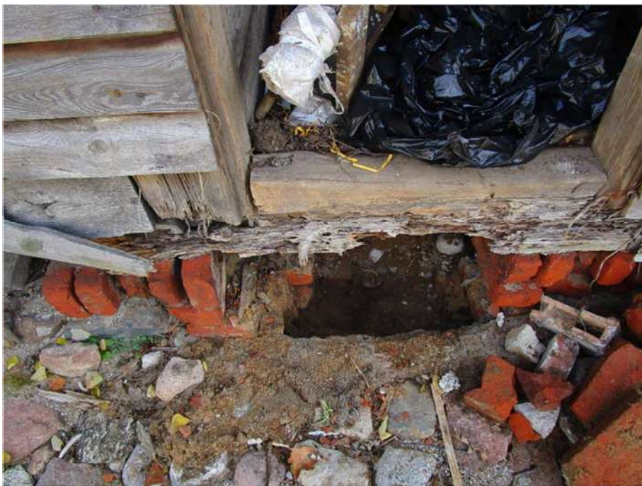
Nuotrauka Nr. 18. Pamatų kasiniai K-1 ir K-2. Nustatytas pamatų įgilinimas ~40 cm nuo dabartinio lygio t.y. 13 cm plyta ant kanto, ~25 cm lauko akmenys su skiediniu. Ties išvieta pamatai išgriauti, apatinis vainikas supuvęs. Pamatų storis ~26÷30 cm. Pamatas atremtas ant smėlingo grunto.
