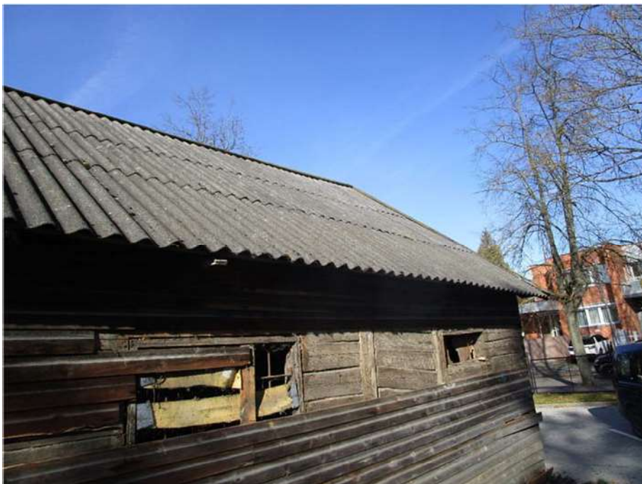
Nuotrauka Nr. 4. Fasado fragmentas ašyje „B“ tarp ašių „1-3“ su dailylenčių atodangomis. Atsidengė fasado langai, stulbinė (svilinė) sienų konstrukcija, apatinis vainikas. Priekiniame plane matosi lauko akmenų nuogrinda įrengta, tvarkant gyvenamą namą. Langas tarp ašių „1-2“ pirminis su stakta. Garažo langas išpjautas atskirai, įrengtu rėmu ir metalinėmis grotomis. Sienojai tarp svylių suskersavo dėl apatinio vainiko netekčių.
