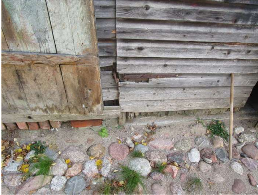
Nuotrauka Nr. 15. Fasado ašyje „A“ fragmentas ties durimis ir vartais. Pamatai lauko akmenų su keraminių plytų ant kanto viršutine eile. Varčios dviejų lentų sluoksnių lentų vertikaliai ir horizontaliai, vėliau apkaltos dailylentėmis. Vyriai ir skersiniai autentiški. Nuogrinda lauko akmenų.
