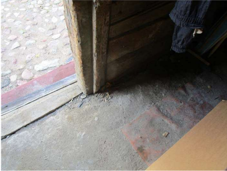
Nuotrauka Nr. 31. Buvusio garažo betoninės grindys ir perimetro apibetonavimas.
