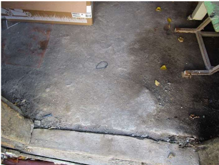
Nuotrauka Nr. 32. Buvusio garažo betoninės grindys ir perimetro apibetonavimas.
