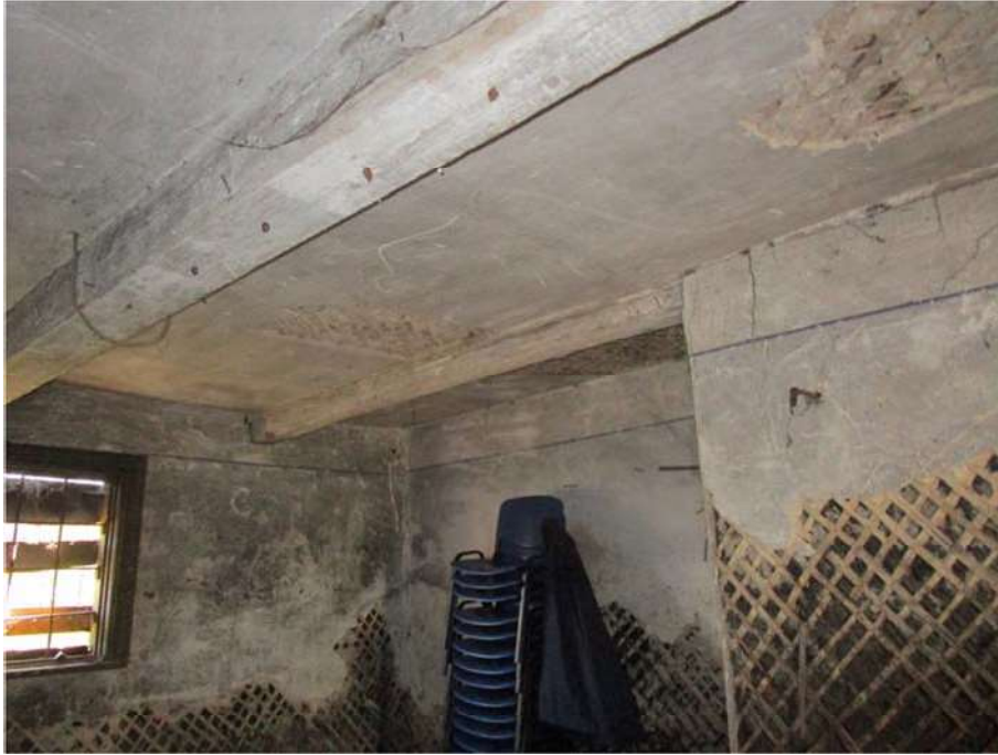
Nuotrauka Nr. 27. Garažo sienų ir perdangų konstrukcija. Pertvaros iš pusrasčių tinkuotos su balanomis ant tolio sluoksnio. Sienos rąstų švilinės konstrukcijos tinkuotos su balanomis. Perdangos dvigubos lentų ant medinių sijų, tinkuotos su balanomis. Sijos dažytos.
