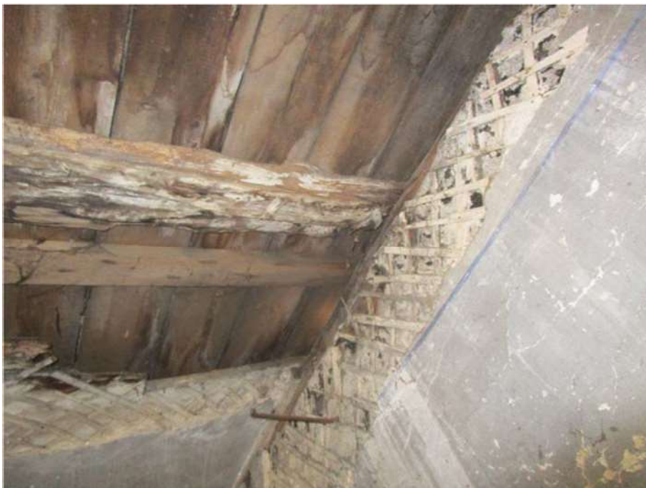
Nuotrauka Nr. 28. Garažo sienų ir perdangų konstrukcija. Pertvaros iš pusrasčių tinkuotos su balanomis ant tolio sluoksnio. Sienos rąstų švilinės konstrukcijos tinkuotos su balanomis. Perdangos dvigubos lentų ant medinių sijų, tinkuotos su balanomis. Sijos dažytos.
