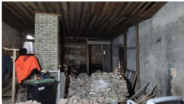
2 pav. Sapiegų rezidencijos, trinitorių vienuolyno ir ligoninės komplekso arklidžių vidaus patalpos bendras vaizdas į pietų pusę
