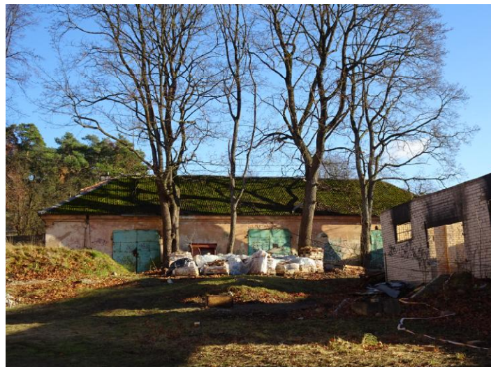
2. Pastato vaizdas iš kiemo pusės. Medžiai auga per arti pastato išorinės sienos, todėl jų šaknys ardo pastato pamatus.
