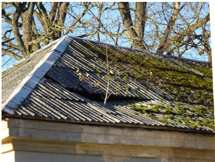
7. Stogo danga susidėvėjusi, stogas įlūžęs, pastatas neturi lietaus vandens nuvedimo sistemos, dėl to drėgmės veikiami išorinė pastato siena.
