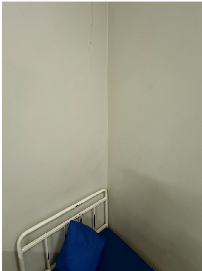
Areštinės patalpose sienose fiksuojami vertikalūs įtrūkiai
