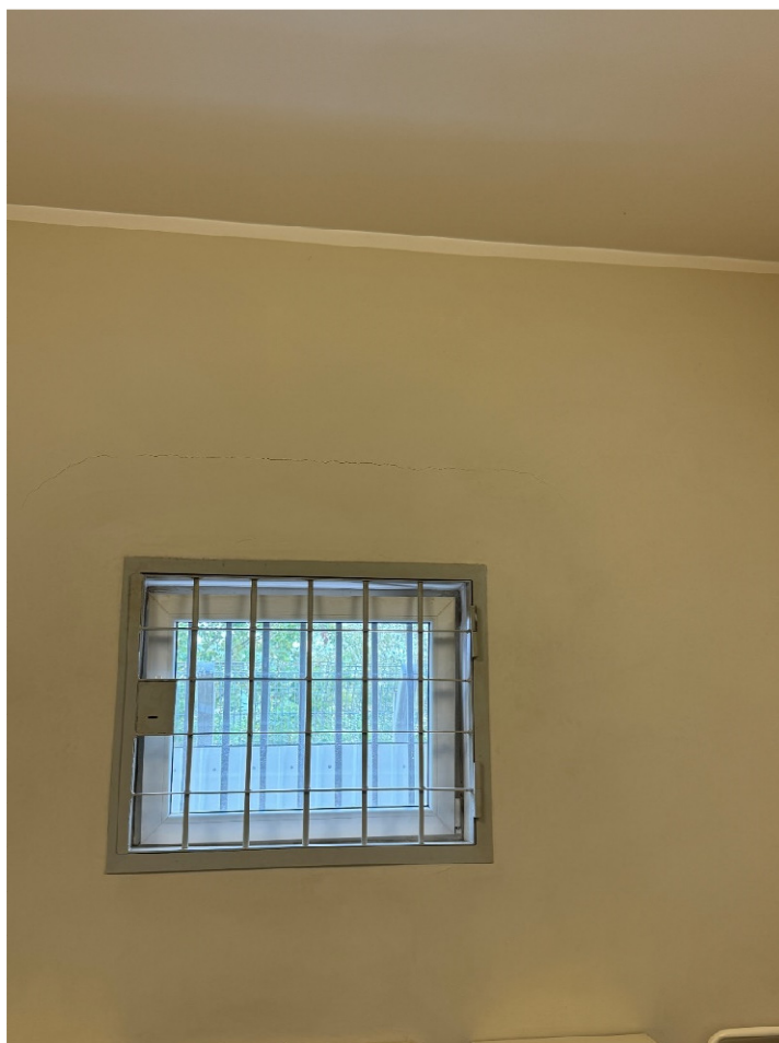
Areštinės patalpose sienose fiksuojami horizontalūs įtūriai (Patalpa 1-58)
