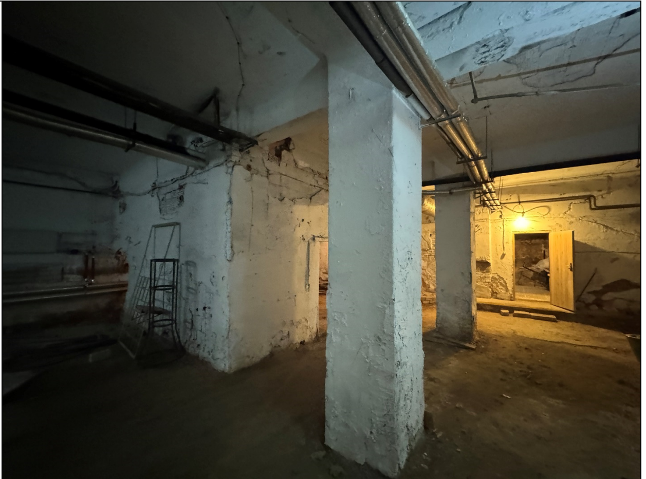
Bendras pusrūsio patalpų vaizdas (neremontuota dalis)
