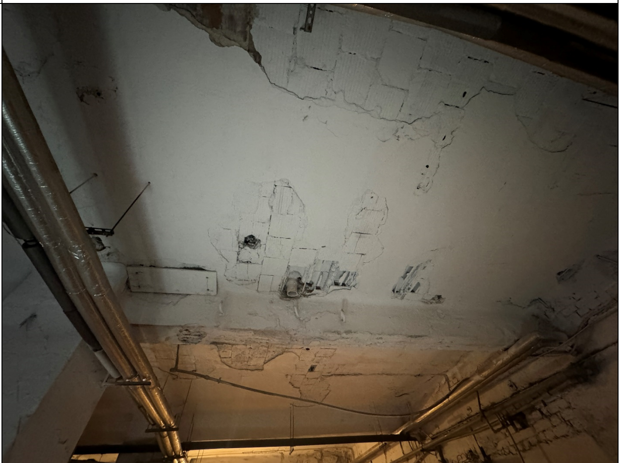
Surenkamos keraminių blokelių perdangos bendras vaizdas
