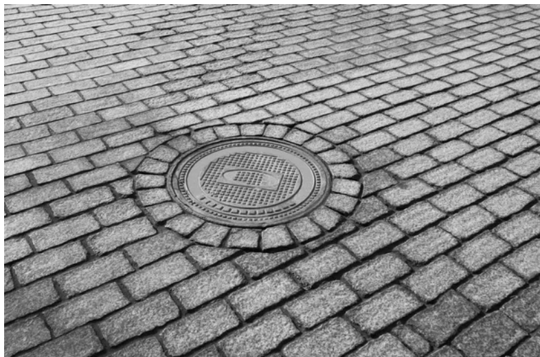
Pav. 18 Siūlomas šulinių liukų tako dangoje įrengimo principas.
