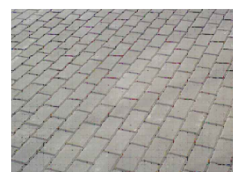
Aikštelių danga- betono trinkelų
