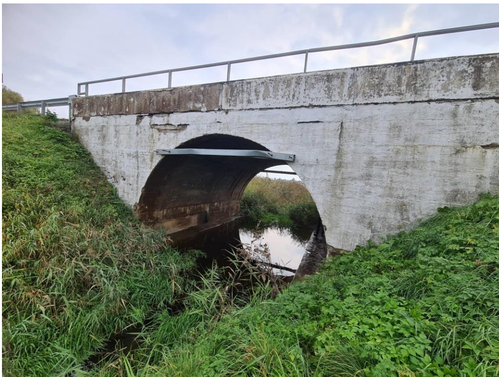
2 pav. Tilto fasadas aukštupio pusėje.
