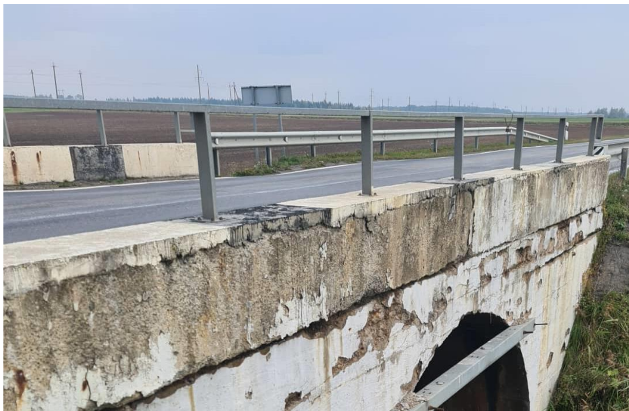
5 pav. G/b atitvarai sutrūkę, pažeistas apsauginis betono sluoksnis
