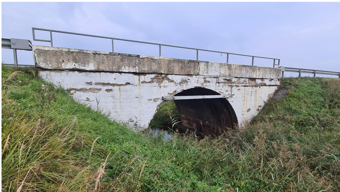
8 pav. Atšokęs apsauginis betono sluoksnis, atsidengusi ir pradėjus koroduoti armatūra
