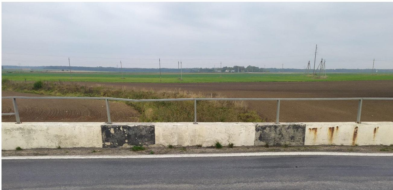
4 pav. Metaliniai tilto turėklai įsikraipę, pažeisti korozijos
