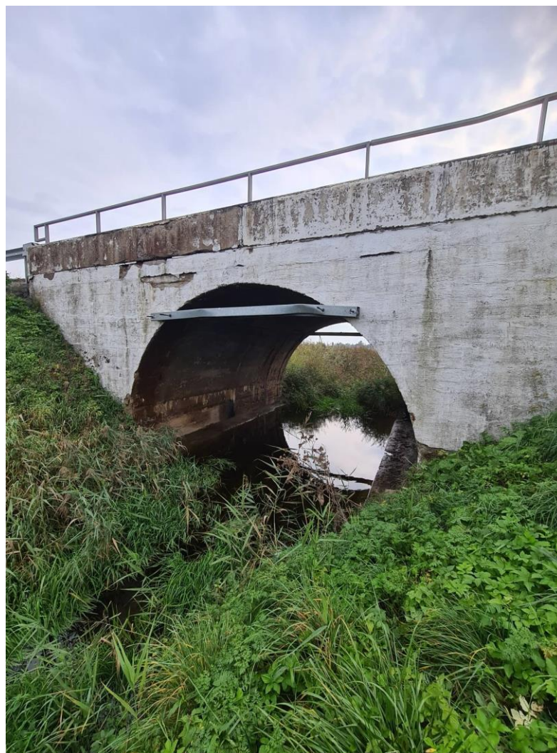
10 pav. Kūgio šlaitai netvarkingi, apaugę žole
