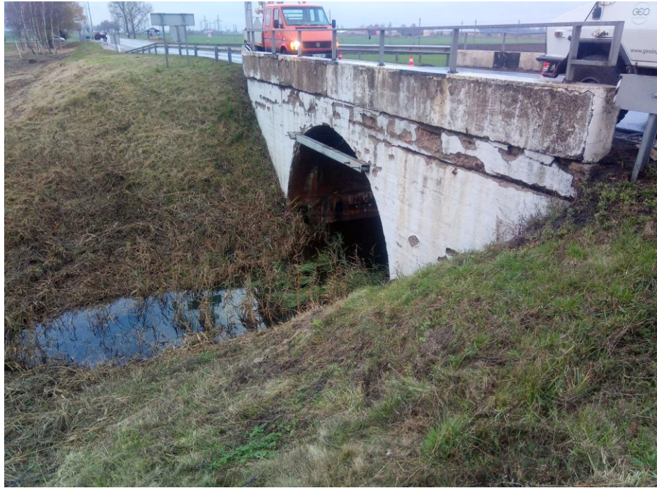
2 pav. Lauko darbai
