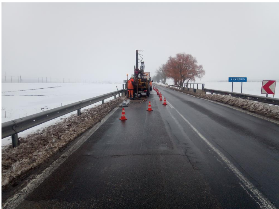
1 pav. Lauko darbai
