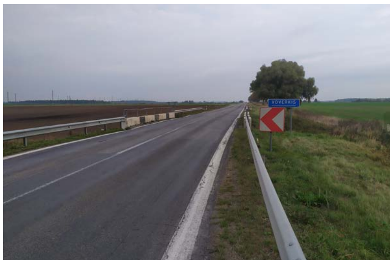
2 pav. Valstybinės reikšmės magistralinio kelio Nr. A12 Ryga*–Šiauliai–Tauragė–Kaliningradas* 35,166 km nagrinėjamų prieigų prie tilto esama situacija
