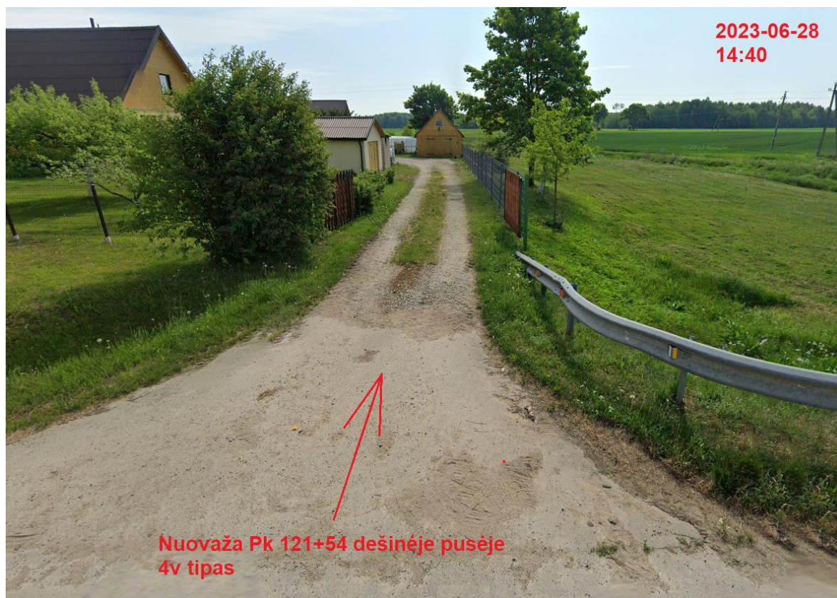
5 pav. Esamos nuovažos Pk 121+54 fotofiksacija.
