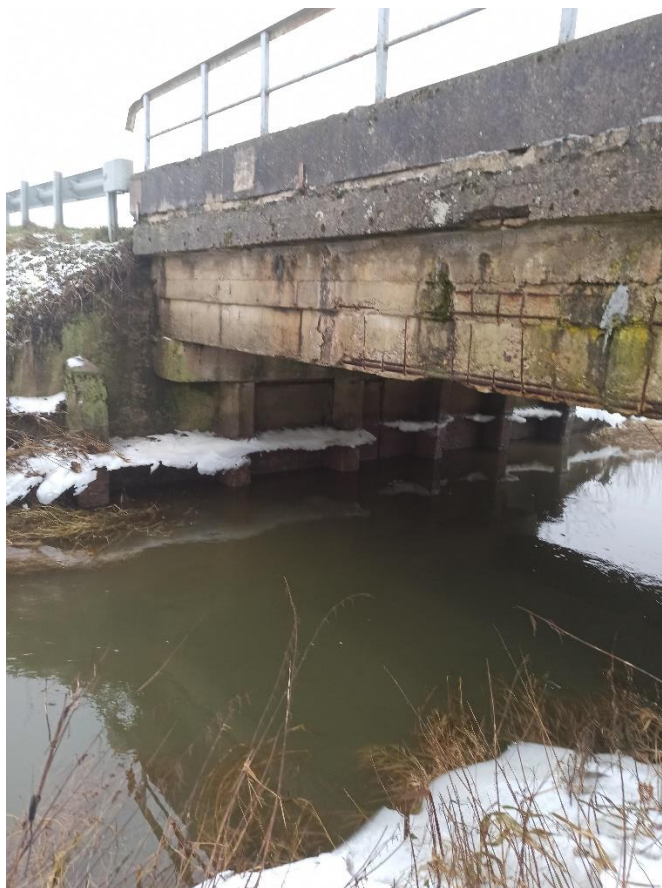
8 pav. Atšokęs sijų apsauginis betono sluoksnis, atsidengusi ir pradėjus koroduoti armatūra
