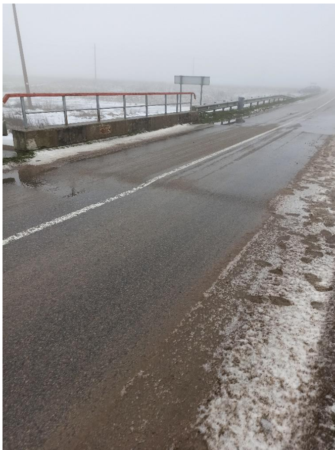
6 pav. Važiuojamoji kelio danga ties pereinamosiomis plokštėmis pasėdusi
