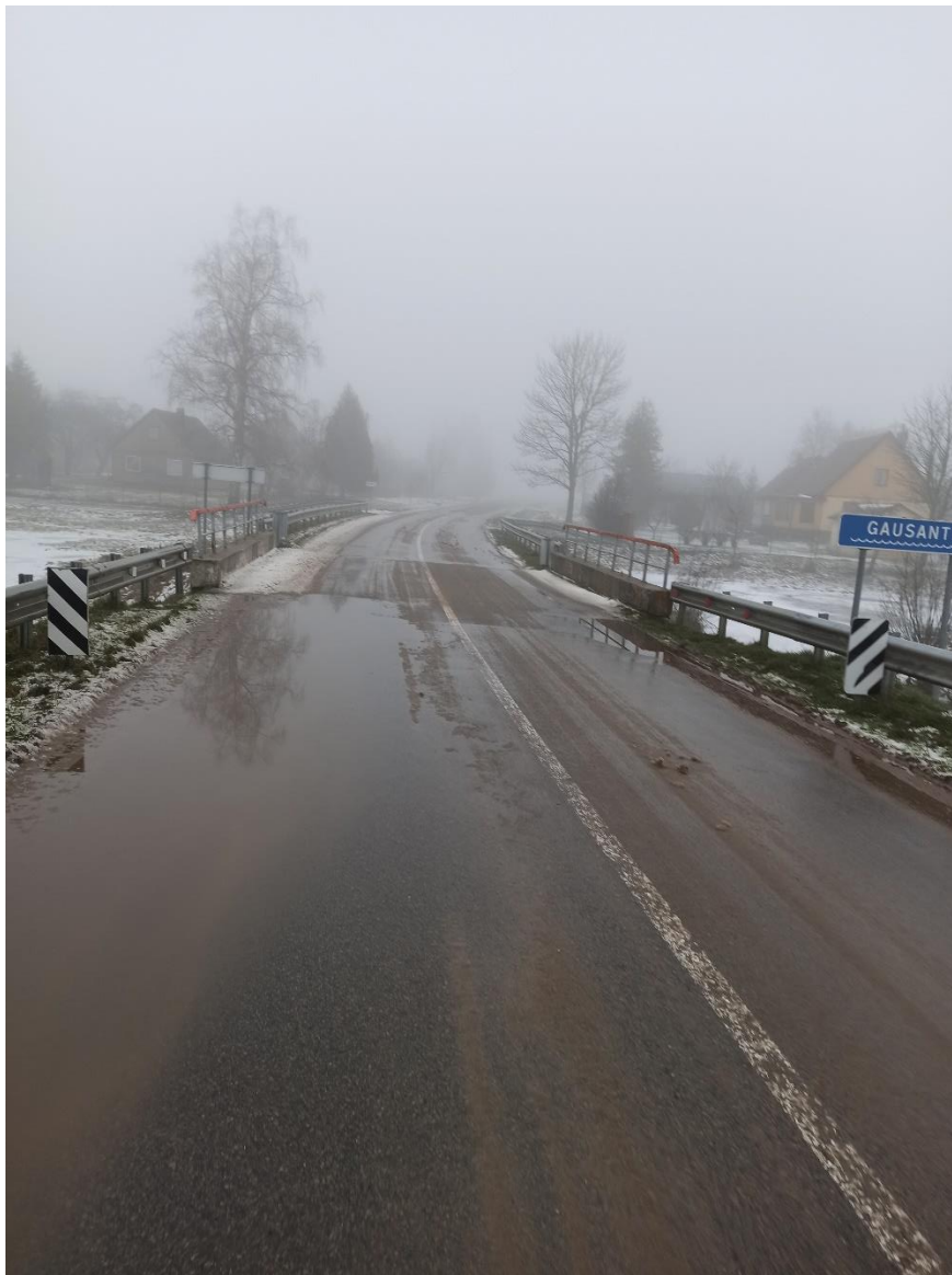
1 pav. Tilto vaizdas nuo kelio į Tamošių pusę
