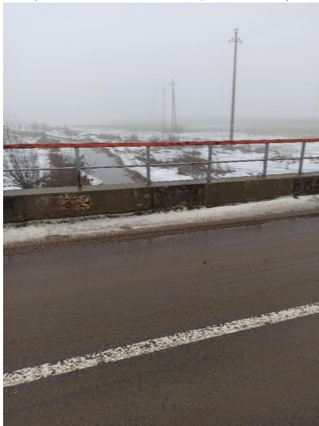
5 pav. G/b atitvarai sutrūkę, pažeistas apsauginis betono sluoksnis
