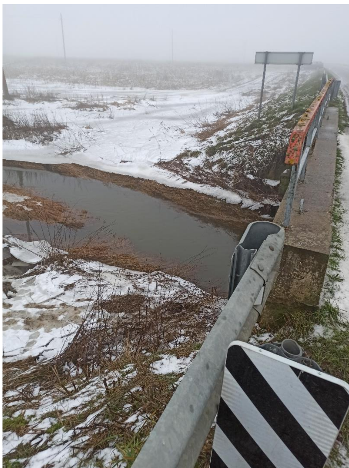
12 pav. Kūgio šlaitų defektai
