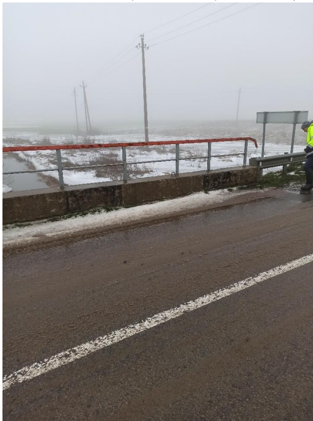
4 pav. Metaliniai tilto turėklai pažeisti korozijos
