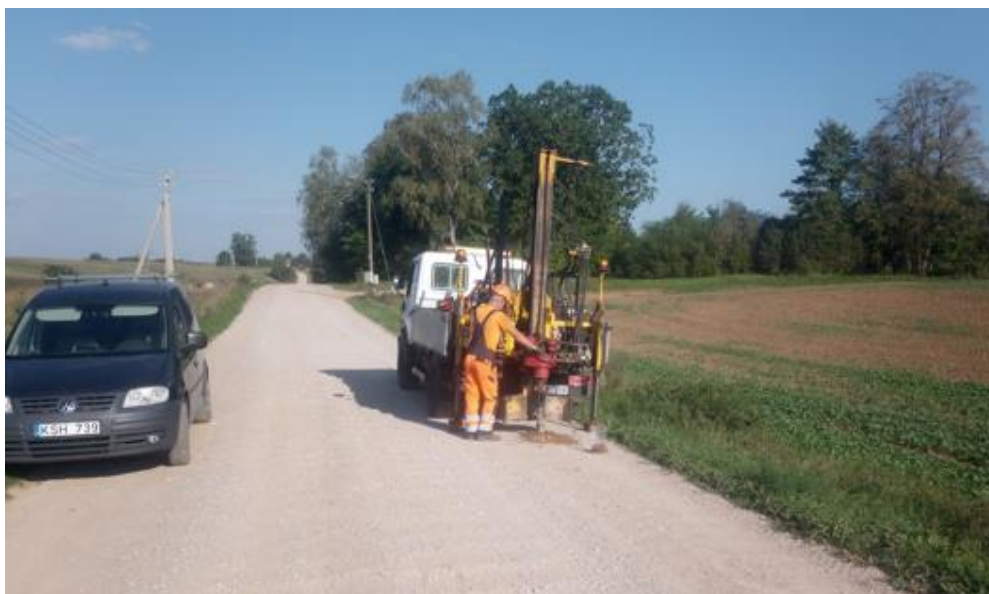
1 pav. Lauko darbai
