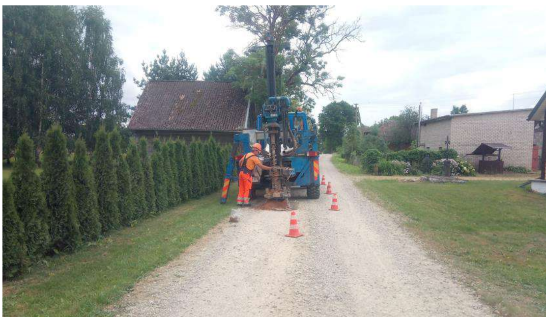
1 pav. Lauko darbai
