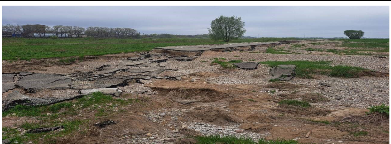
24 pav. 4212 kelio 19,93 km. Nuplauta kelio dangos konstrukcija ir sankasa
