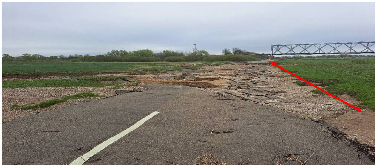
28 pav. 4212 kelio 20,10 km. Nuplauta kelio dangos konstrukcija ir sankasa. Dešinėje pusėje yra slėnis
