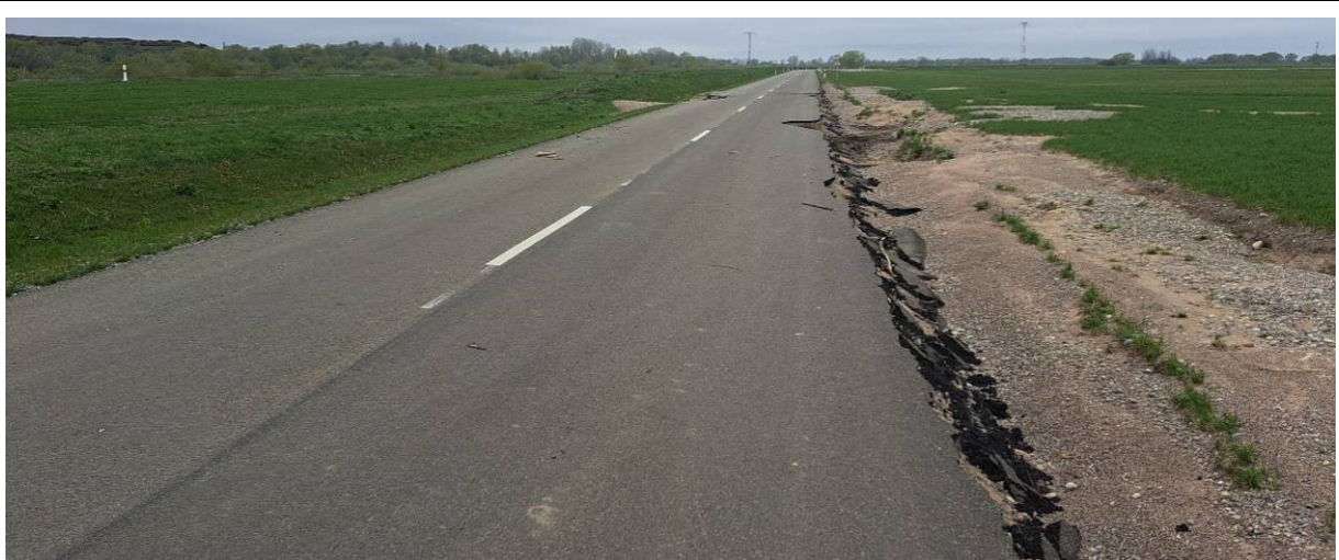
3 pav. 4212 kelio 18,66 – 19,10 km. Nuplautas ir suardytas kelio dangos kraštas kairėje kelio pusėje
