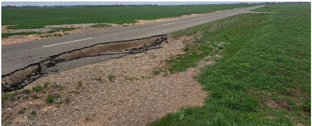
2 pav. 4212 kelio 18,66 km. Nulaužtas kelio dangos kraštas dešinėje kelio pusėje, išplautas dangos kraštas – kairėje kelio pusėje
