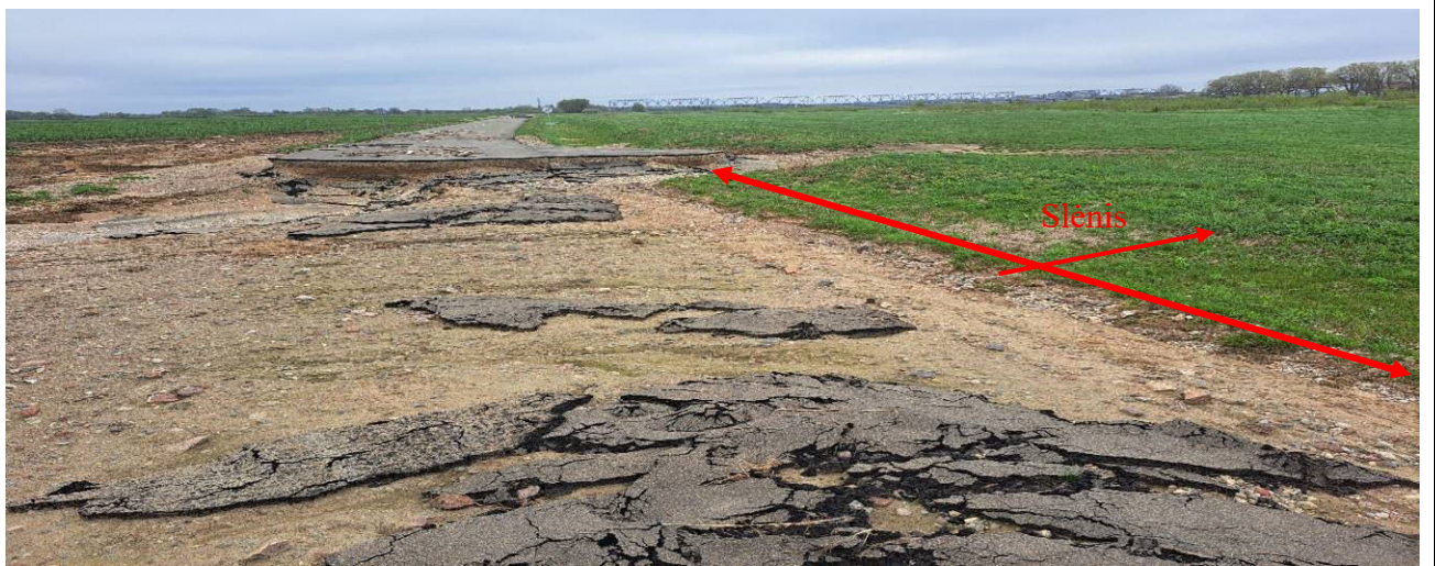
10 pav. 4212 kelio 19,13 -19,18 km. Nuplauta kelio dangos konstrukcija ir sankasa. Pažymėtoje zonoje yra slėnis, todėl upės vanduo ir ledai išplovė vagą kelyje
