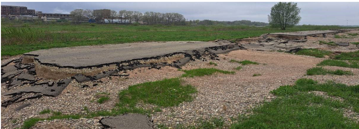
27 pav. 4212 kelio 19,96 – 20,10 km. Iš abiejų kelio pusių nuplautos dangos konstrukcijos ir sankasos
