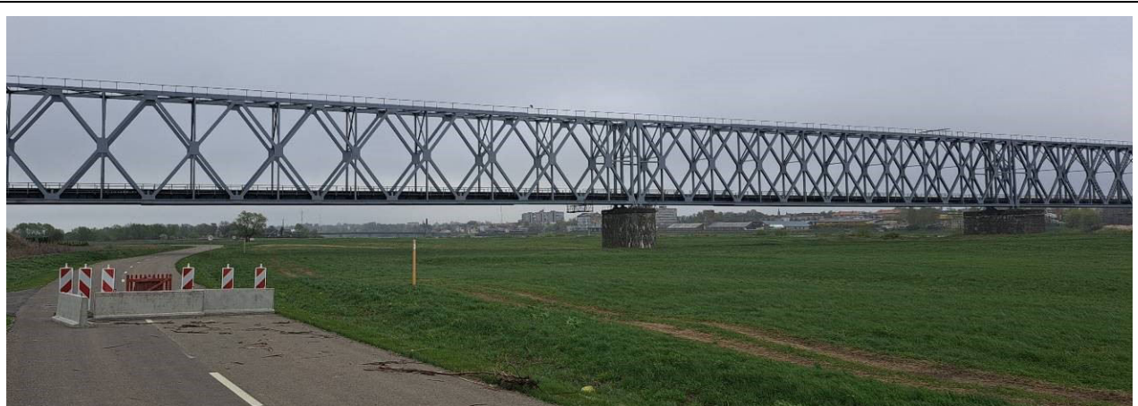
32 pav. 4212 kelio 20,20 km. Kelio vizualinė apžiūra ir matavimai atlikti iki šios vietos. Už aptvėrimų pažaidų su dangos konstrukcija neužfiksuota
