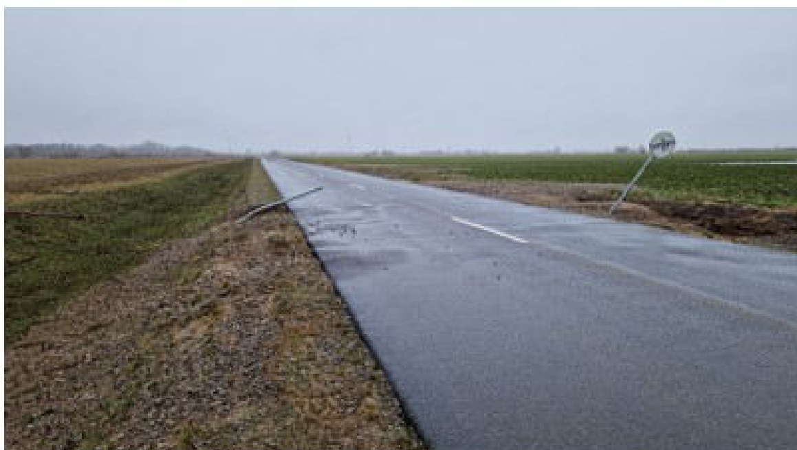
4 pav. deformuoti vertikalūs kelio ženklai abiejose pusėse 19,10km
