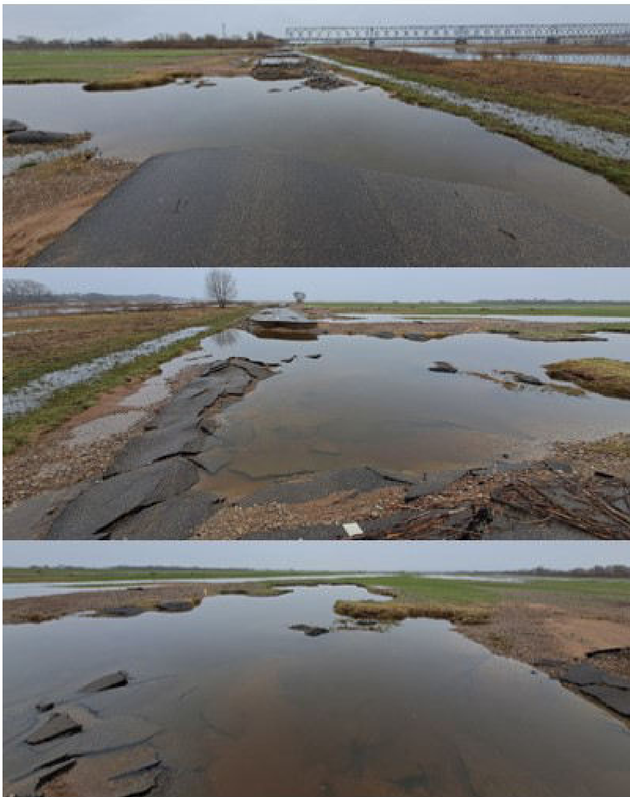
11 pav. nuplauta kelio dengos konstrukcija ir žemės senkasa 19,93km
