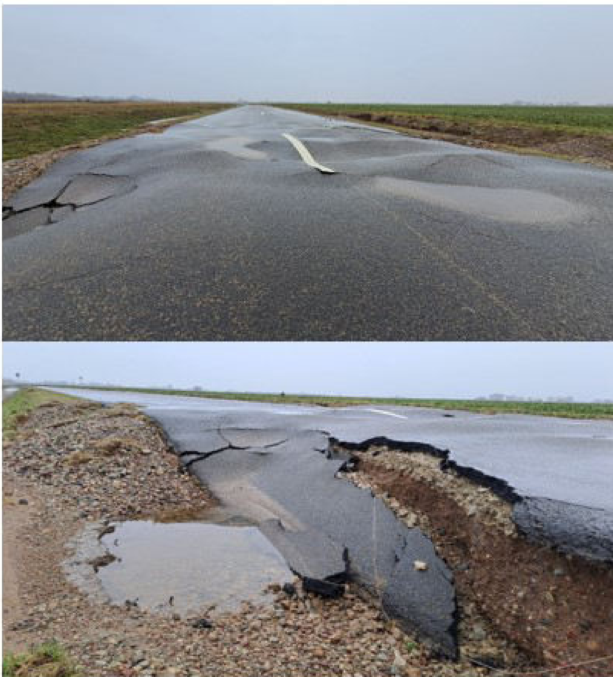
7 pav. deformuota kelio dalis 19,31km
