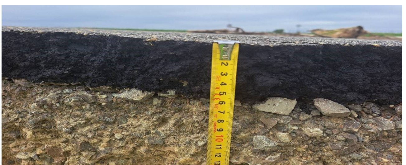
12 pav. 4212 kelio 19,13 -19,18 km. Atsitiktinėje vietoje pamatavus nustatyta, kad asfalto dangos storis – 6,0 cm
