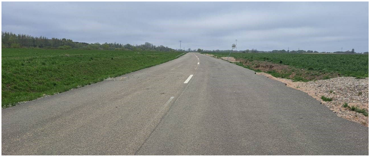
4 pav. 4212 kelio 18,66 – 19,10 km. Nuplautas ir suardytas kelio dangos kraštas kairėje kelio pusėje
