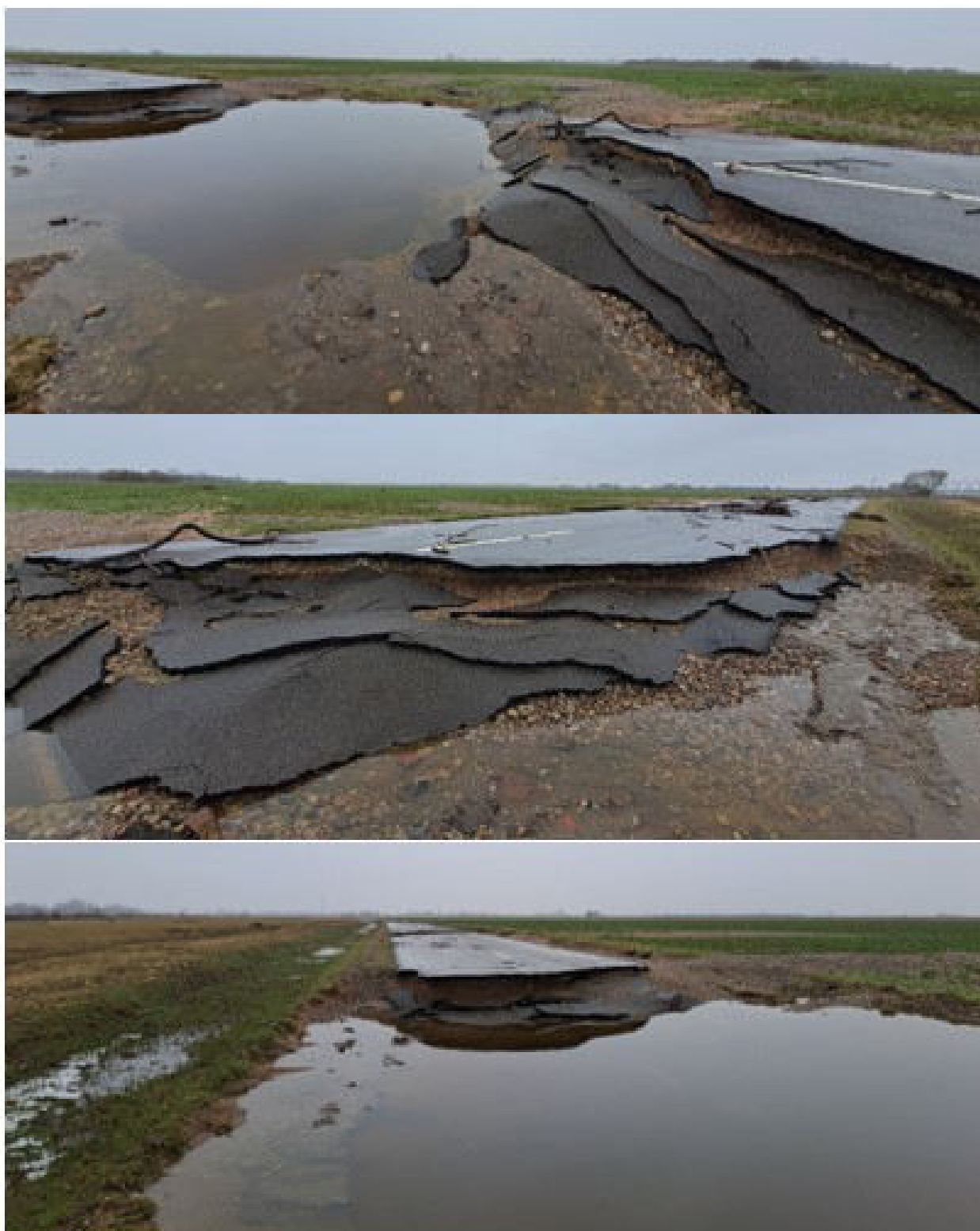
9 pav. nuplysuta kelio dangos konstrukcija ir žemės sankasa 19,37km
