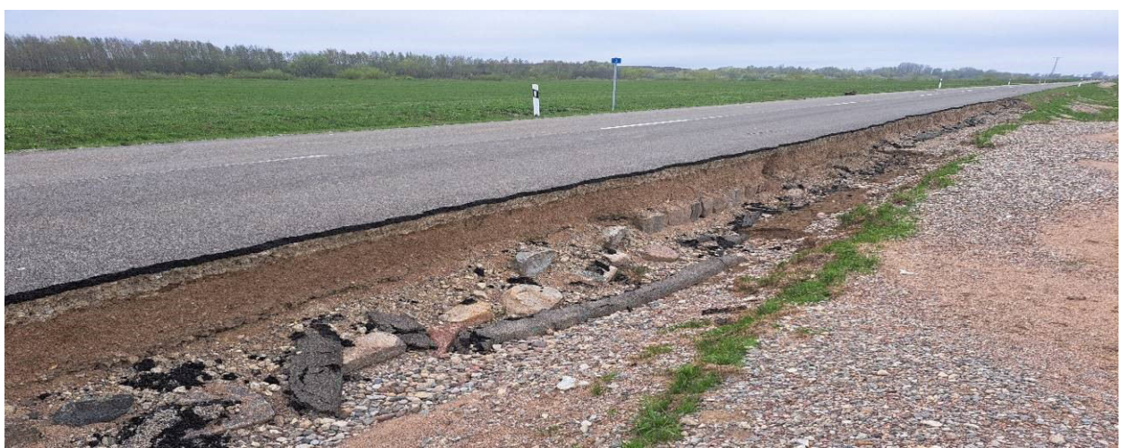
17 pav. 4212 kelio 19,33 - 19,37 km. Kairėje kelio pusėse nuplautas ir suiręs kelio dangos kraštas, paplauta kelio sankasa
