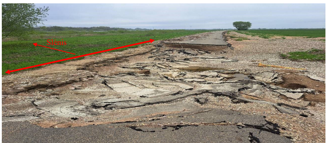
23 pav. 4212 kelio 19,93 km. Nuplauta kelio dangos konstrukcija ir žemių sankasa. Raudonom rodyklėm pažymėtoje zonoje yra slėnis, todėl upės vanduo ir ledai išplovė vagą kelyje
