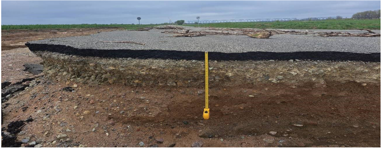
13 pav. 4212 kelio 19,13 -19,18 km. Atsitiktinėje vietoje pamatavus nustatyta, kad asfalto dangos storis – 7,0 cm, skaldos sluoksnio storis – 20 cm
