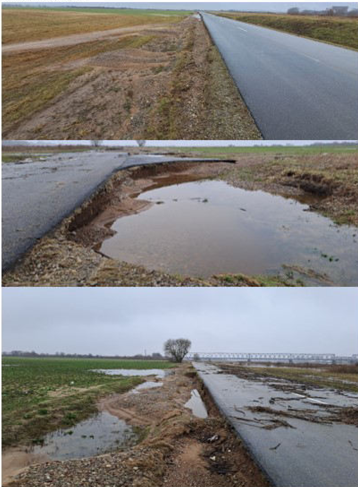
1 pav. nuplautos kelkraštis abiejose kelio pusėse 18,66 – 20,06 km
