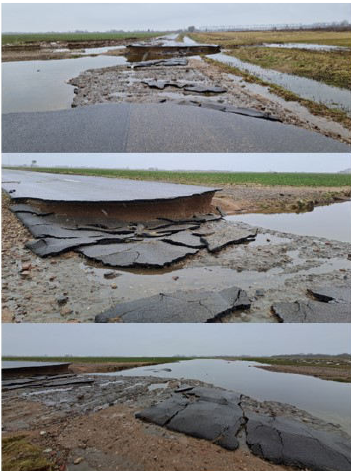
5 pav. nuplauta kelio dangos konstrukcija ir žemės sankasa 19,13 – 19,18km
