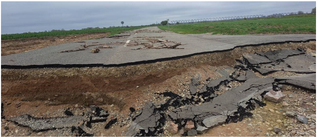
14 pav. 4212 kelio 19,13 -19,18 km. Nuplauta kelio dangos konstrukcija ir sankasa
