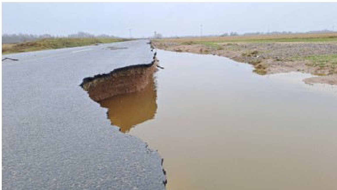
3 pav. nuplauta kelio dangos konstrukcija ir žemės senkasa dešinėje pusėje 18,72 km
