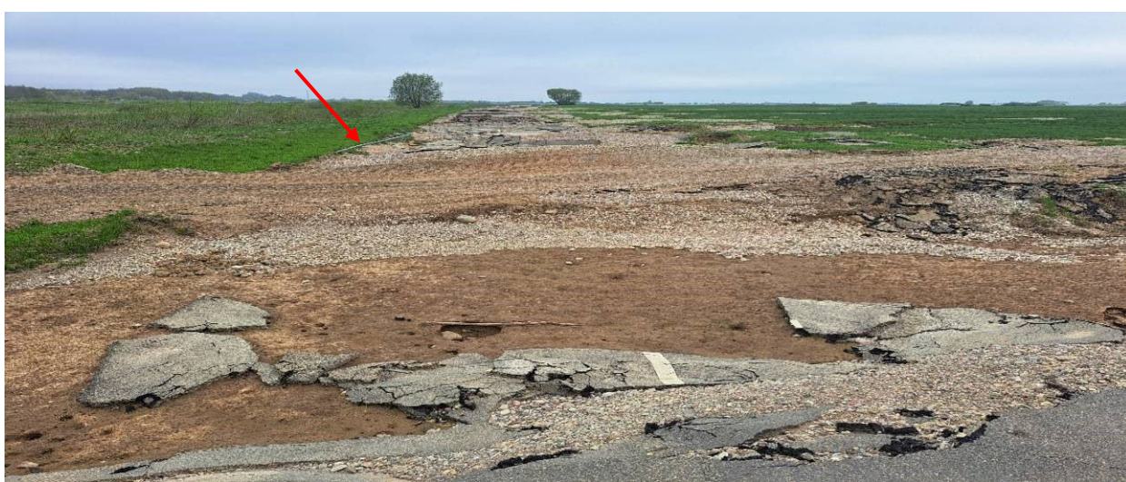
29 pav. 4212 kelio 20,10 km. Nuplauta kelio dangos konstrukcija ir sankasa. Kairėje pusėje nuverstas kelio ženklas
