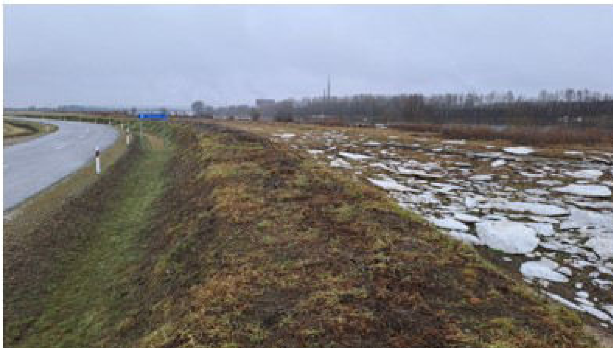
16 pav. Remontuojamo ruožo pradžios situacija. Esamas apsauginis pylimas, kuris tęsiasi iki 18,7 km
