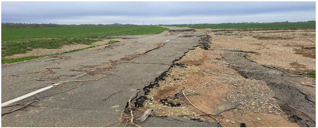
16 pav. 4212 kelio 19,33 - 19,37 km. Kairėje ir dešinėje kelio pusėse nuplautas ir suiręs dangos kraštas, paplauta kelio sankasa
