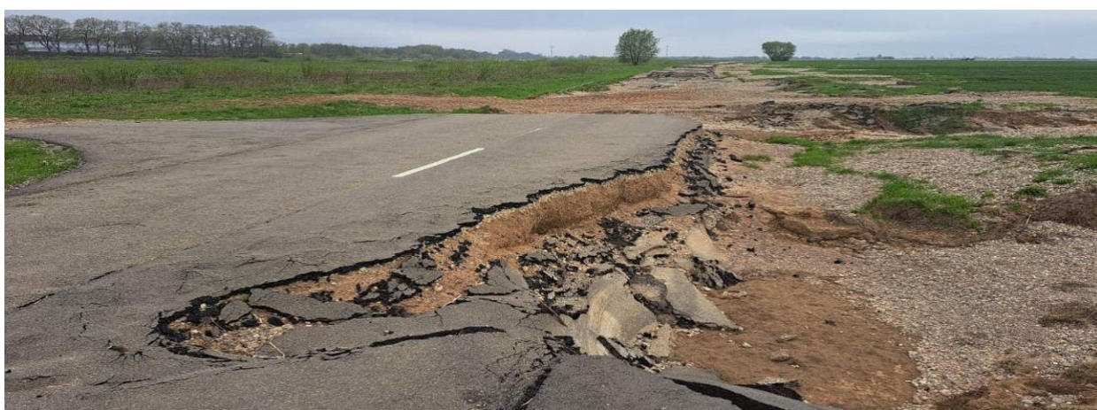
30 pav. 4212 kelio 20,10 km. Nuplauta kelio dangos konstrukcija ir sankasa. Nuplauti ir suirę kelio dangos kraštai
