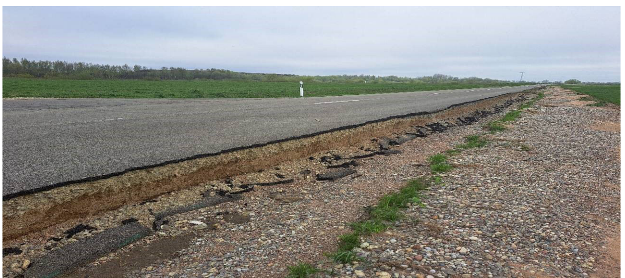
5 pav. 4212 kelio 18,66 – 19,10 km. Nuplautas ir suardytas kelio dangos kraštas kairėje kelio pusėje
