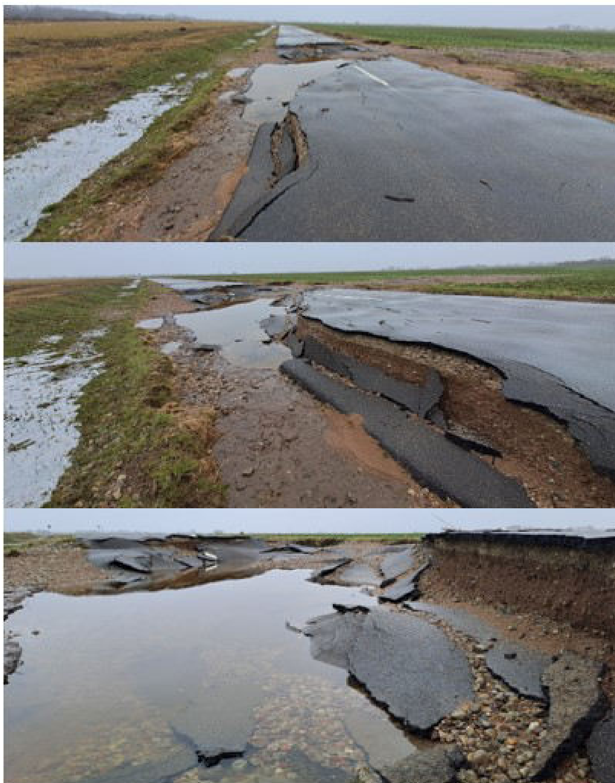
8 pav. nuaplauta kelio dangos konstrukcija ir žemės sankasa 19,33km
