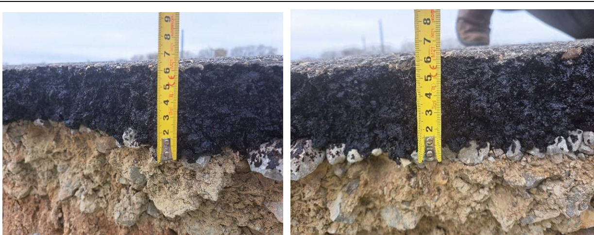
18 pav. 4212 kelio 19,33 - 19,37 km. Skirtingose vietose pamatavus asfalto dangos storį gauta, kad jis yra 6,0 cm ir 6,5 cm
