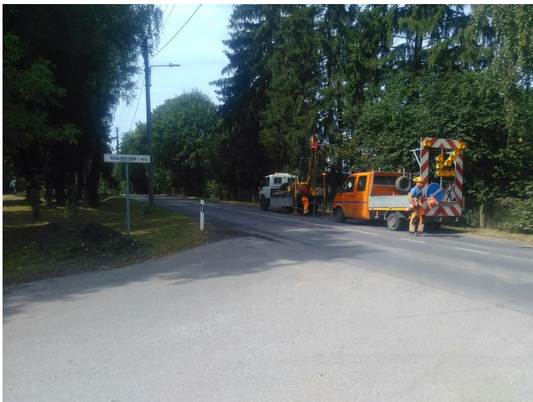
1 pav. Lauko darbai
