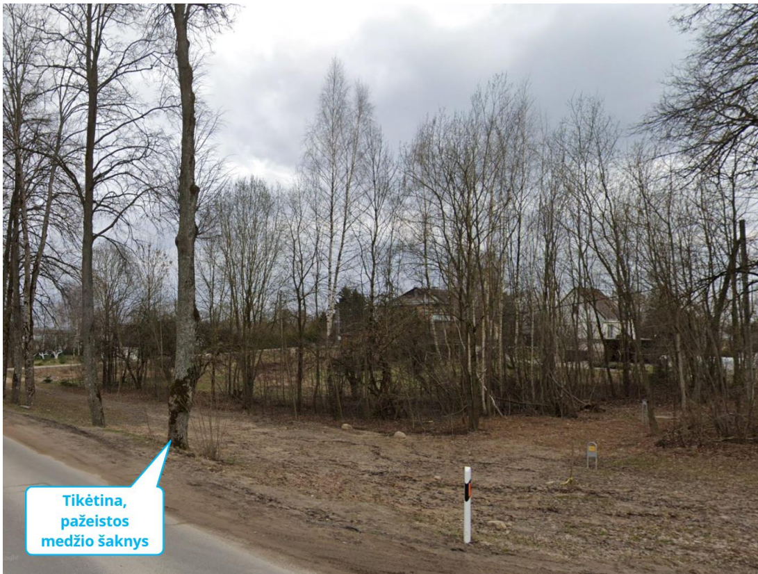
Pav. 5. Tikėtina, pažeistos medžio šaknys atliekant inžinerinių tinklų statybos darbus medžių šaknų apsaugos zonoje.
