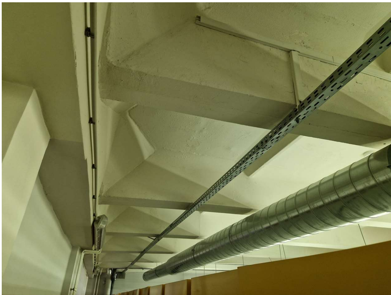
pav. 3 Esamų briaunuotų perdangos plokščių vaizdas
