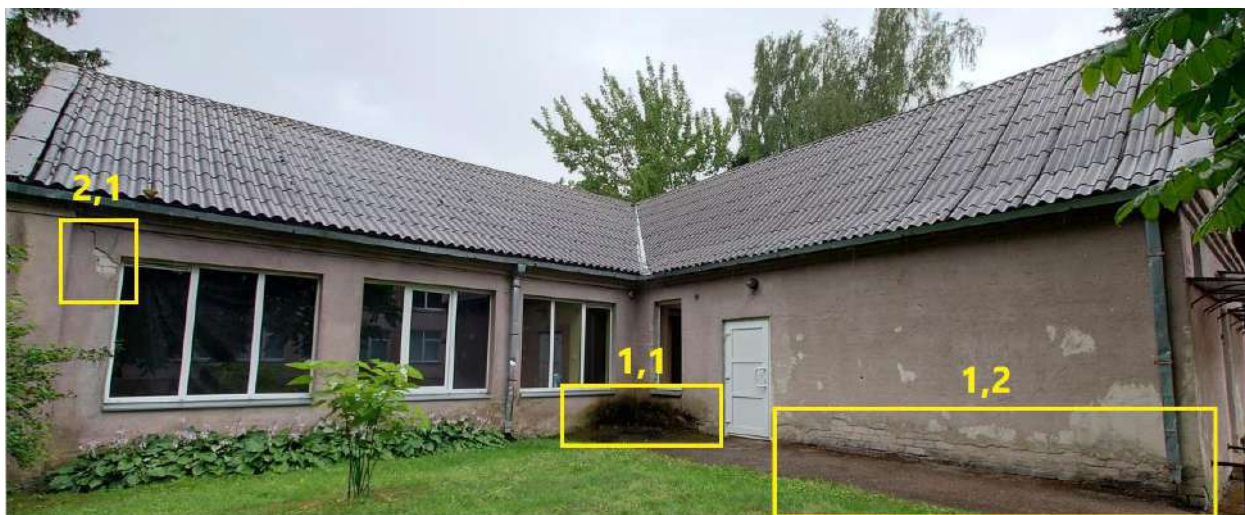
1 pav. Remontuojamo pastato fasado vaizdas.
