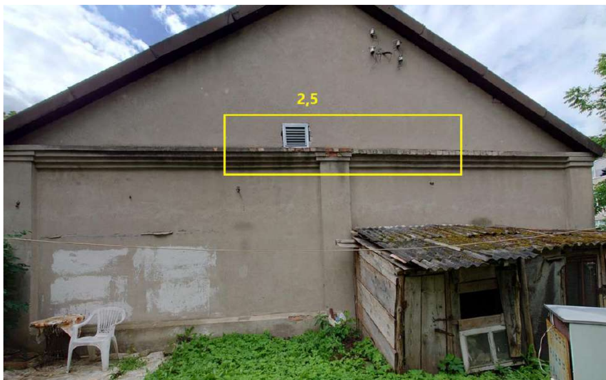
6 pav. Remontuojamo pastato fasado vaizdas
