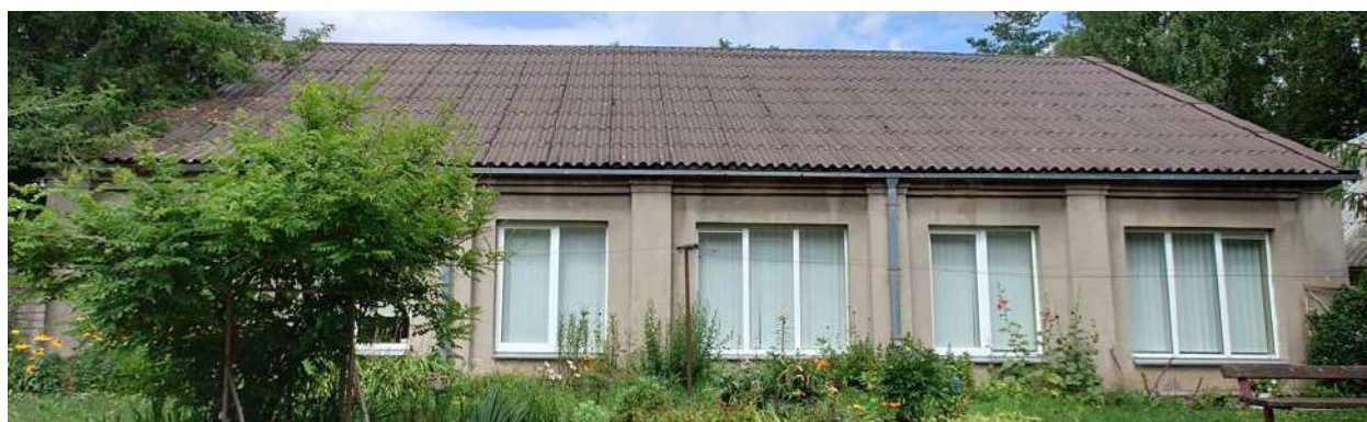
5 pav. Remontuojamo pastato fasado vaizdas.
