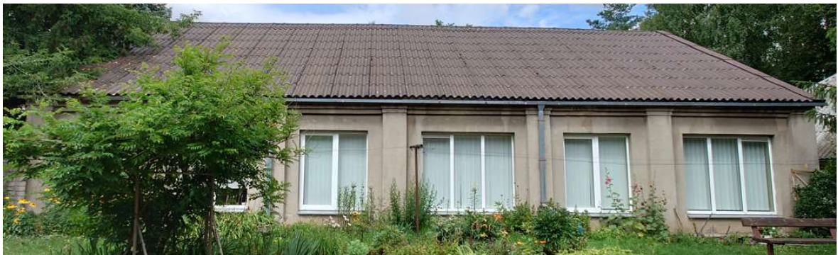
5 pav. Remontuojamo pastato fasado vaizdas.
