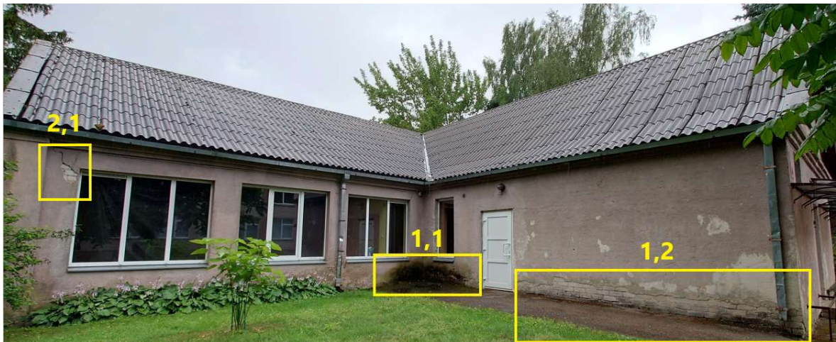
1 pav. Remontuojamo pastato fasado vaizdas.
