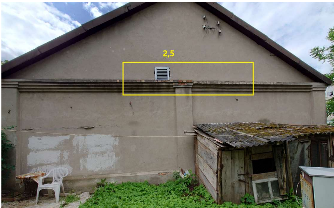
6 pav. Remontuojamo pastato fasado vaizdas
