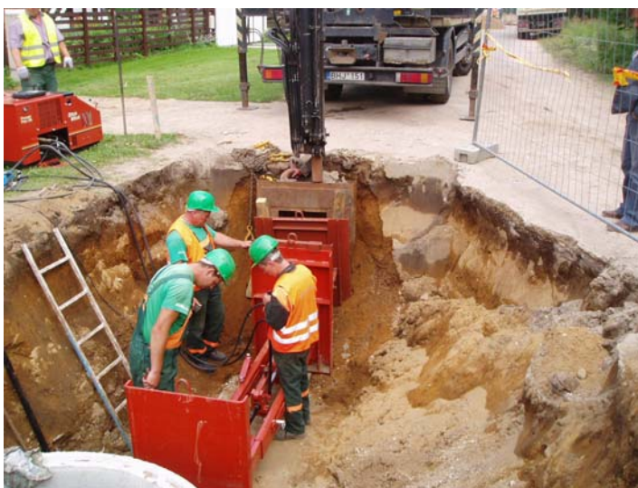
1 pav. Darbas sauso horizontalaus kryptinio gręžimo įrengimu Ditch Witch P80
