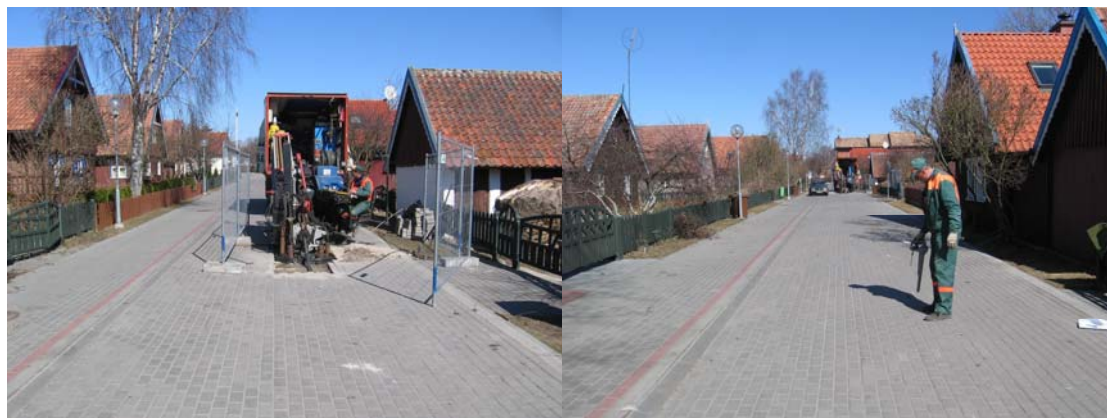
3 pav. Darbas šlapio horizontalaus kryptinio gręžimo įrengimu Grundodrill 15x
