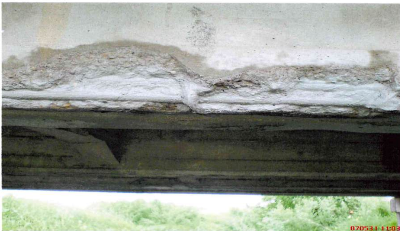
Pav.1 Paruoštos plieninės armatūros gruntavimas antikoroziiniu gruntu Maxrest arba Maxrite-S .
