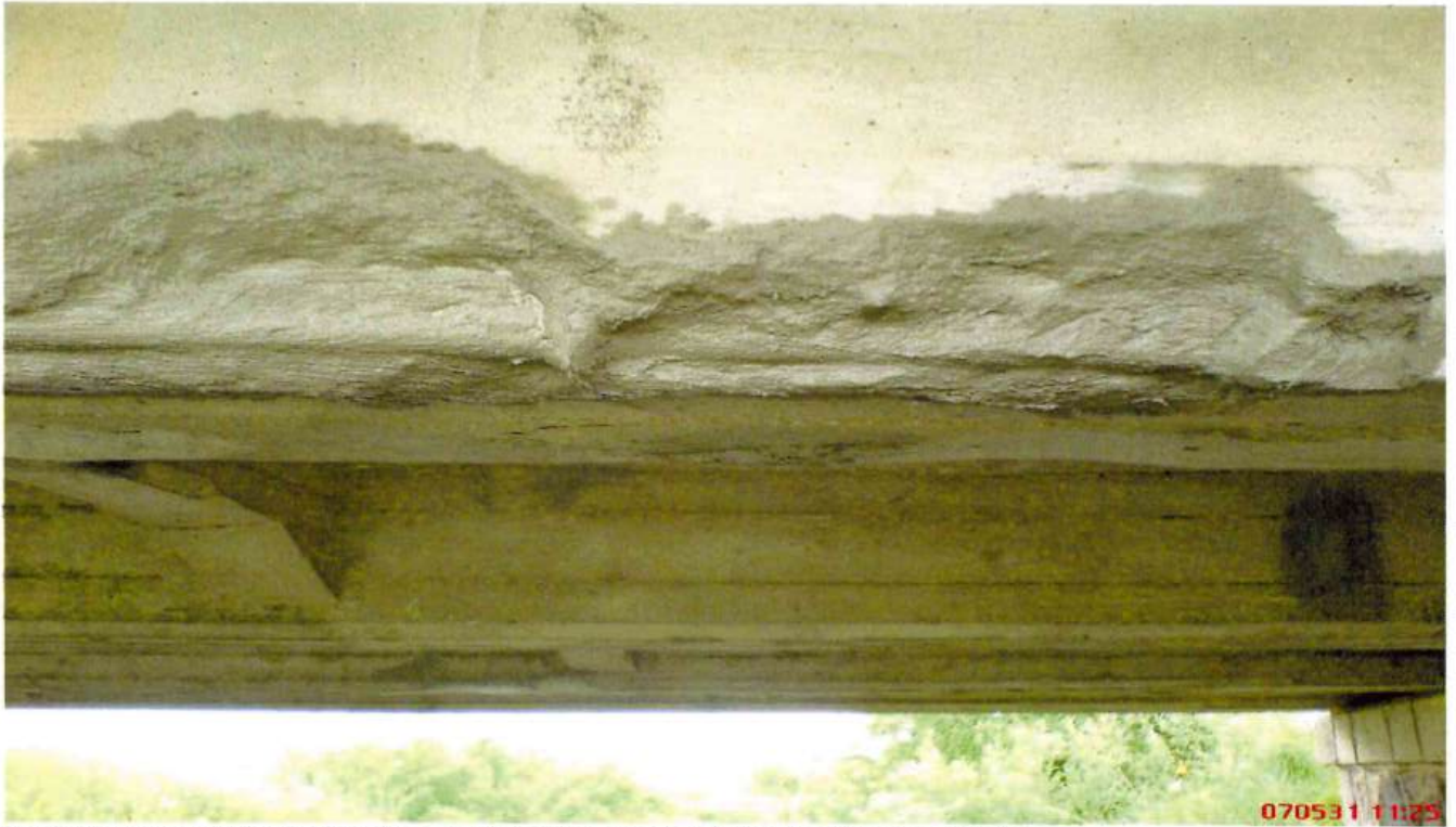
Pav.2 Betono paviršiaus gruntavimas naudojant tepamos konsistencijos Maxrest skiedinį
