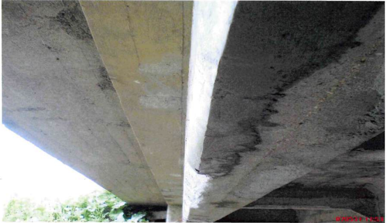
Pav.3 Maxrest betono remonto skiedinio užnešimas
