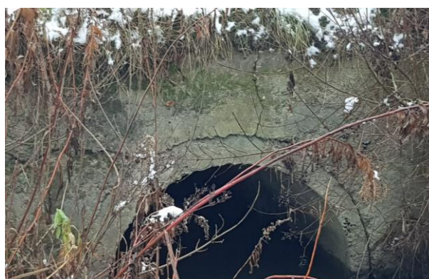
3 pav. Esamos gelžbetoninės d1000 mm vandens pralaidos antgaliai
