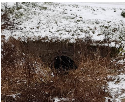
3 pav. Esamos gelžbetoninės d1000 mm vandens pralaidos antgaliai
