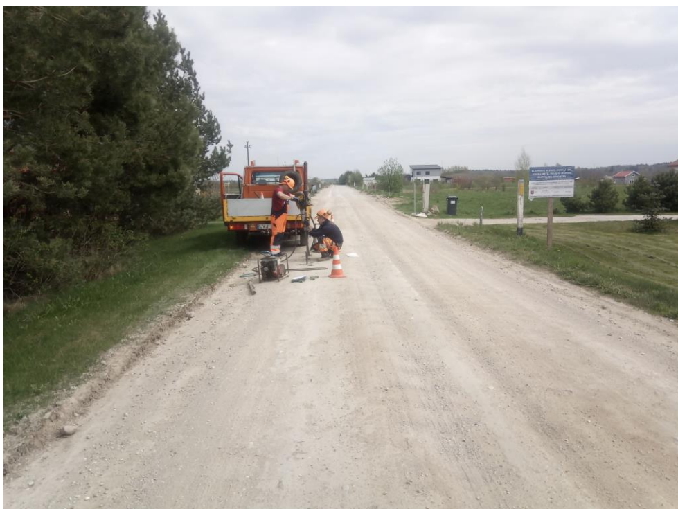
1 pav. Lauko darbai
