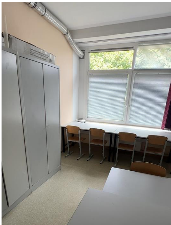
17-18 pav. III-36 patalpos ventiliacija (į lauką išvesta)
