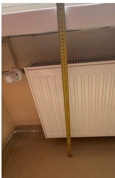
56 pav. Aukštis nuo grindų iki palangės – 68 cm
