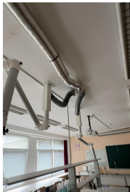
17-18 pav. III-36 patalpos ventiliacija (į lauką išvesta)
