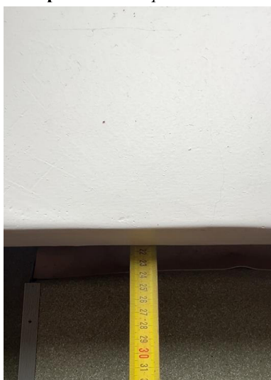
47 pav. Radiatoriaus įgilinimas – 22 cm
