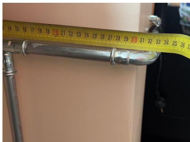
32 pav. Radiatoriaus įgilinimas – 30,5 cm
