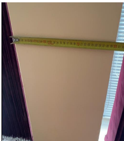
44 pav. Kolonos plotis – 30 cm
