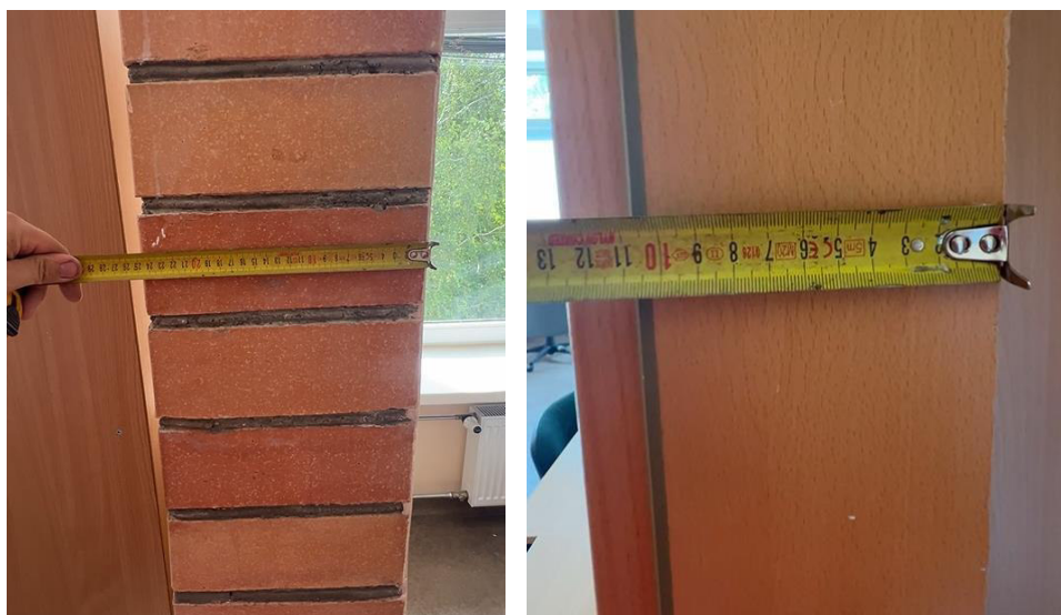
64 pav. Sienos matavimas (išmūryta siena)
