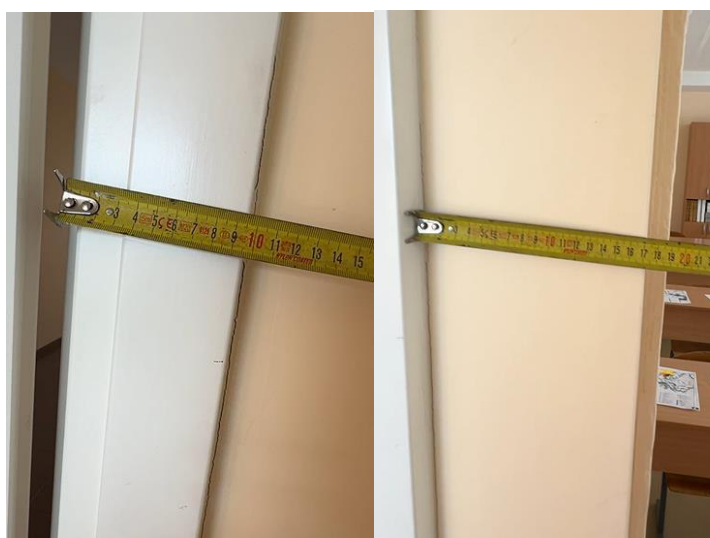
60-61 pav. Sienos storio matavimas (III-31 patalpa)
