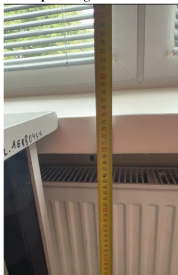
87 pav. Aukštis nuo grindų iki palangės – 69 cm
