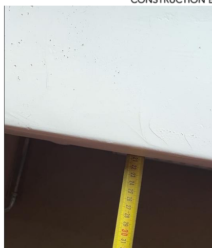
56 pav. Radiatoriaus įgilinimas – 21 cm
