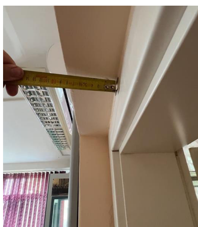
63-64 pav. Sienos matavimas (III-39 patalpa)
