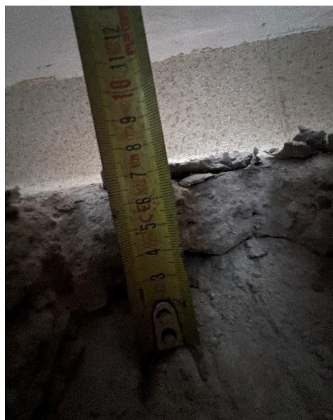
19 pav. Nr. 1. Šurfas – 7 cm betonas
