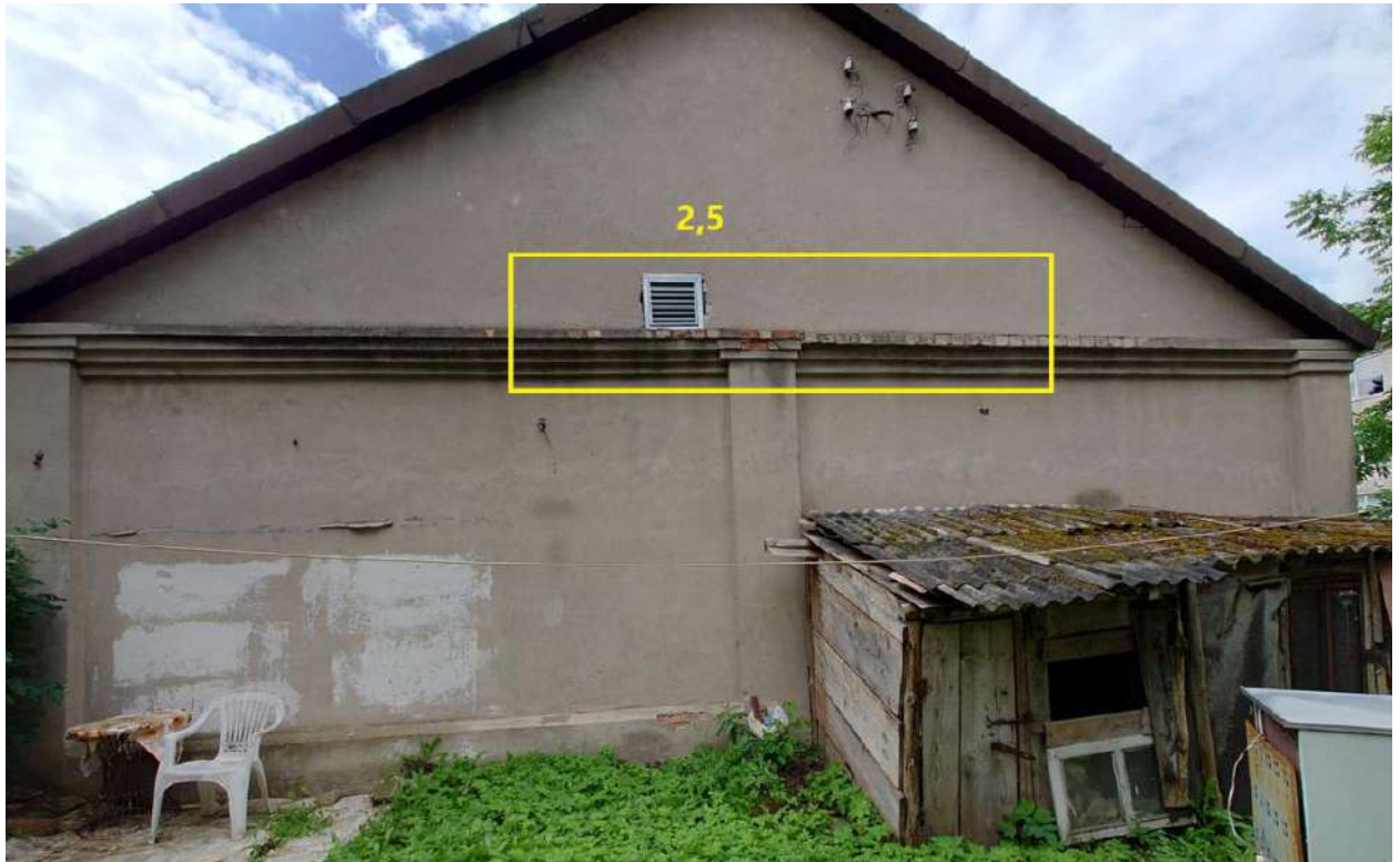
6 pav. Remontuojamo pastato fasado vaizdas
