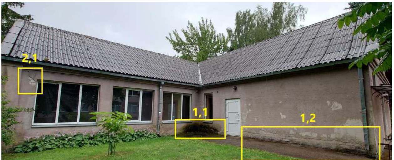
1 pav. Remontuojamo pastato fasado vaizdas.
