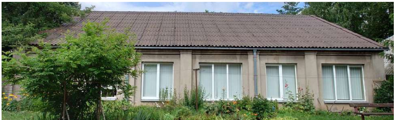
5 pav. Remontuojamo pastato fasado vaizdas.
