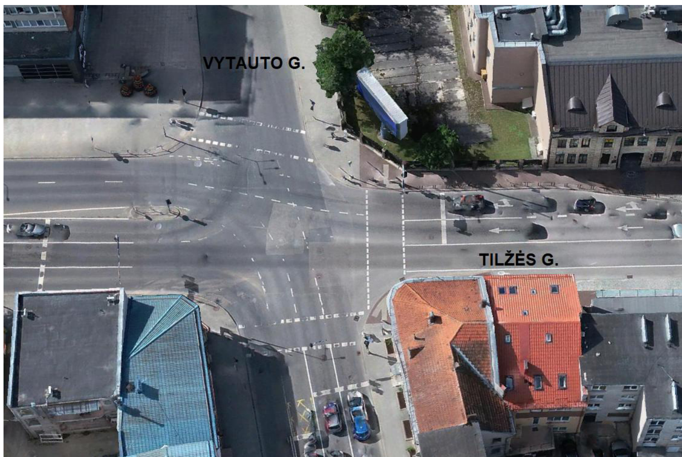
16 pav. Tilžės – Vytauto g. sankryža
